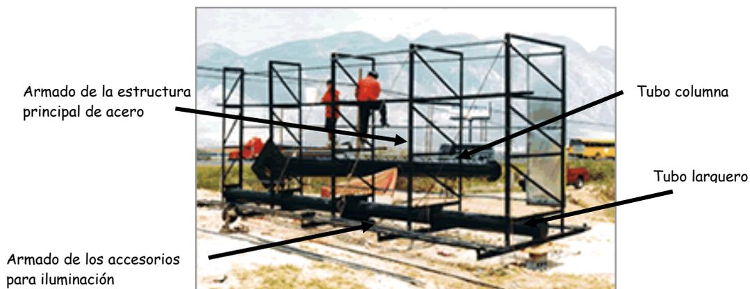
Foto 21. Armado de la estructura del anuncio en campo
