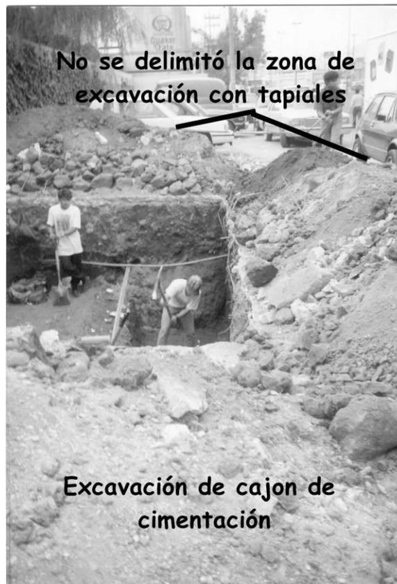
Foto 16. Excavación a mano en caja para la cimentación
