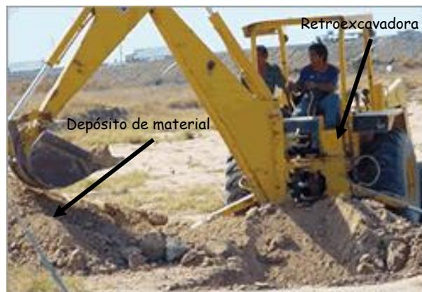
Foto 17. Excavación del terreno por medios mecánicos para desplante de la cimentación
