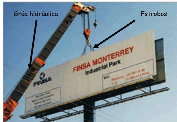
Foto 23. Instalación y montaje del anuncio, con grúas de diversas capacidades, según las necesidades del trabajo
