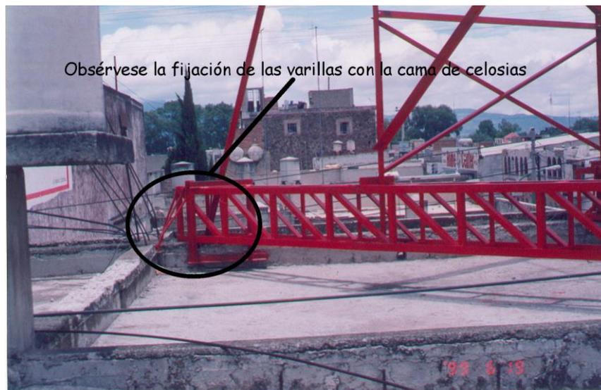
Foto 26. Fijación de la celosía que conforman la cama de viguetas para el desplante del anuncio
