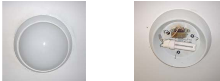
Figura 4.5 LFC en un Luminaria Cerrado Fuente: Philips-Construlita
