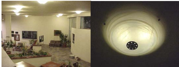
Figura 4.7 Aplicación de LFC's en una Casa Club Fuente: Fotografías de una Casa Club
