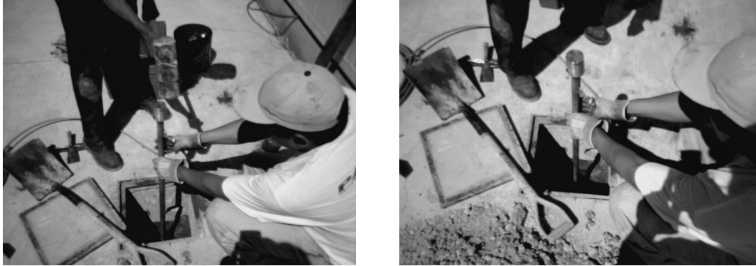
Figura 44.- Instalación de Sistema de Tierras con electrodos.
