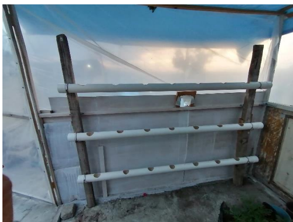
10.2.13: Colocación de canales
