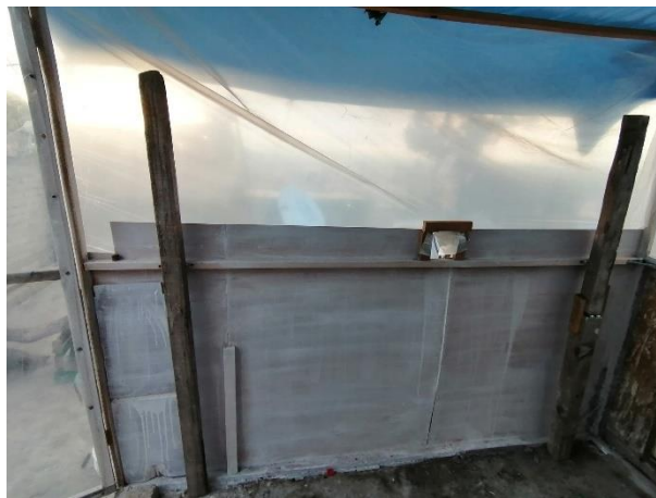
10.2.12: Soportes de canales
