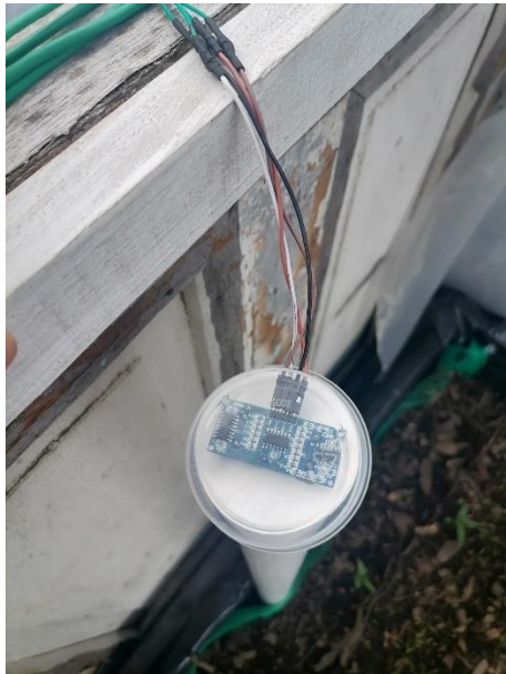
10.3.3.19: Sensor en el tubo de riego de la cama capilar
