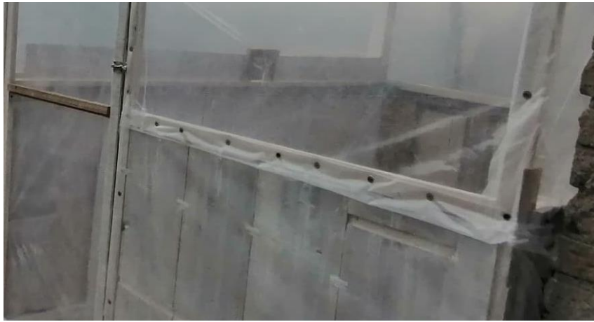
10.2.5: Fijación del plástico a la estructura de madera.
