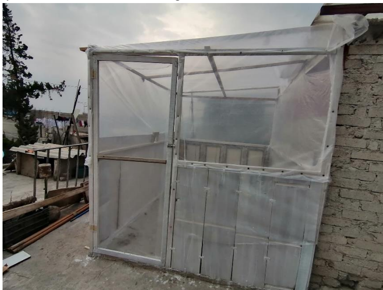
10.2.8: Vista frontal del invernadero terminado.
