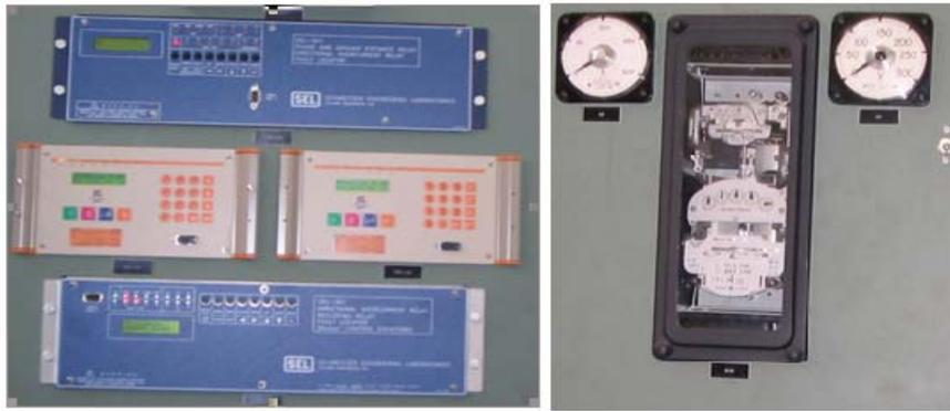
Fig.5.11 Comparación relevador microprocesado y un relevador electromagnético
