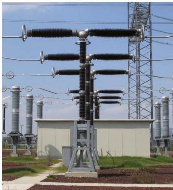
Fig. 3.7 Interruptor de potencia
