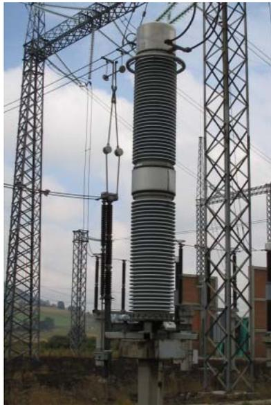
Fig. 3.5 Transformador de potencial
