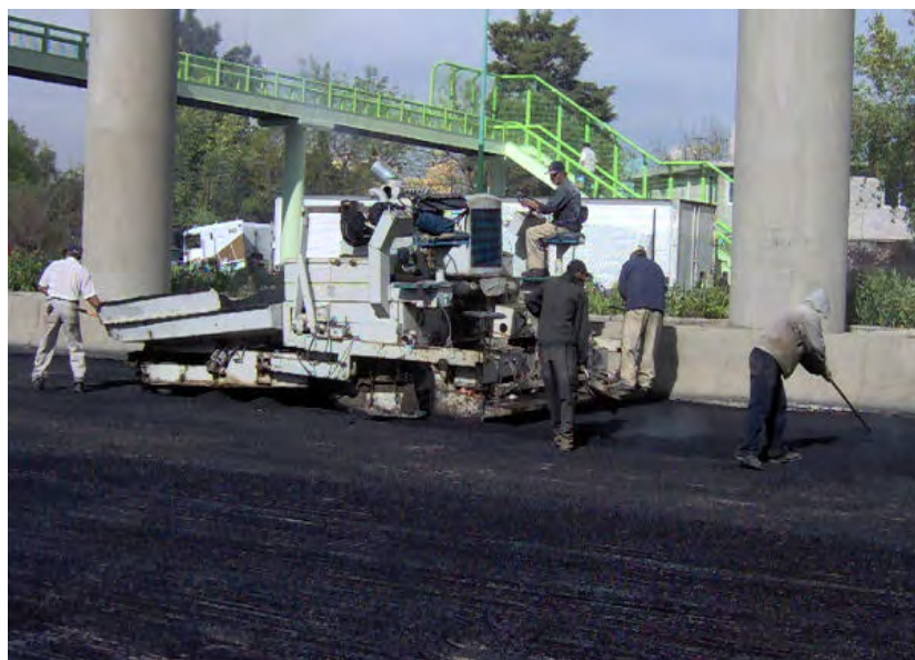
Figura 59. Tendido de carpeta asfáltica.
