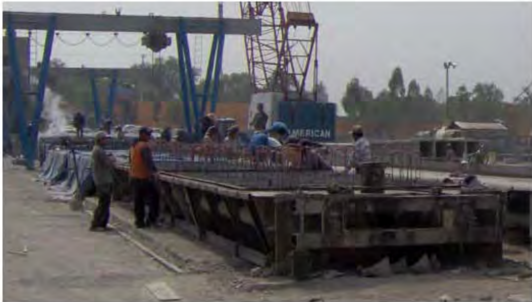
Figura 19. Colocación del acero de refuerzo sobre banca de tensado.
