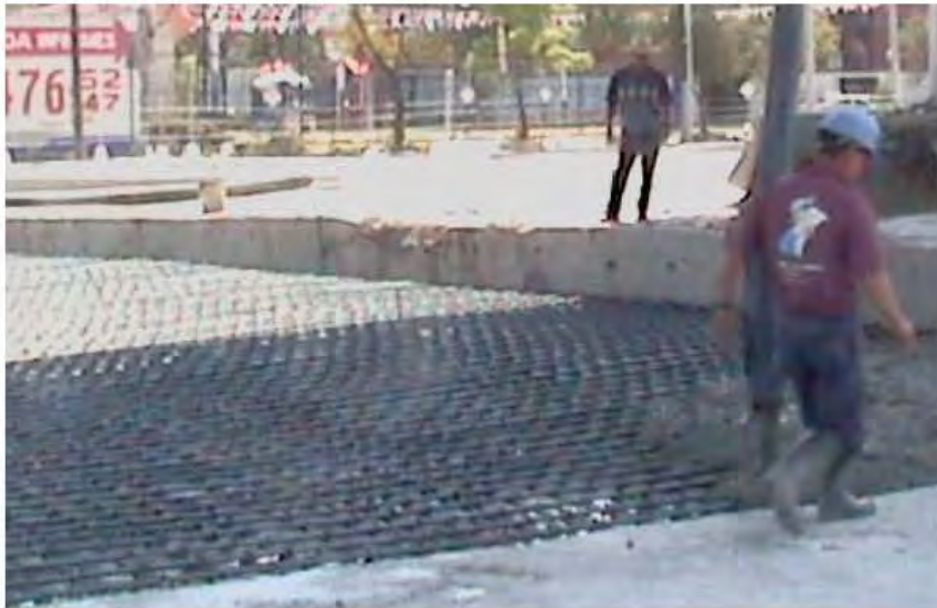
Figura 46. Armado y colado de la losa de compresión.
