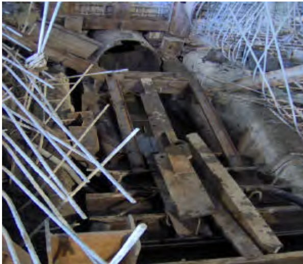
Figura 72. Izq. Arreglo de perfiles para el hincado de tubería, Der. Unión del segundo tramo de tubería con soldadura de arco eléctrico.
