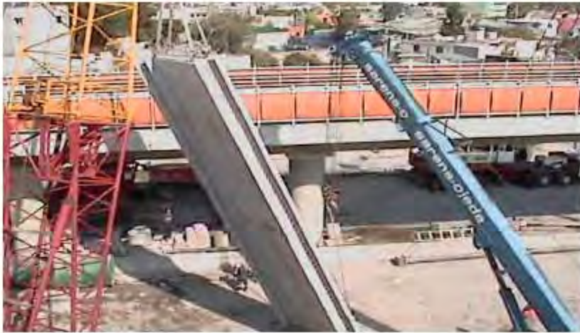
Figura 64. Izaje de muro para cárcamo de bombeo.
