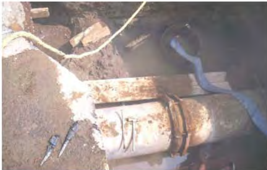
Figura 6. Tubería de A.P. lista para iniciar el corte.
