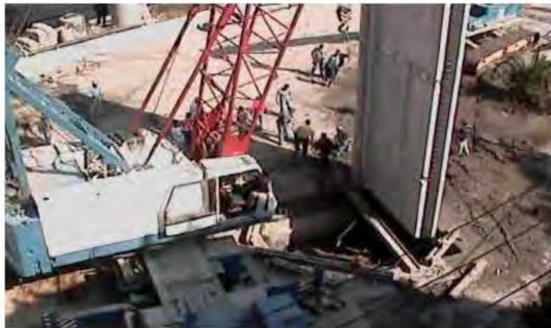
Figura 65. Hincado de muro para cárcamo de bombeo.
