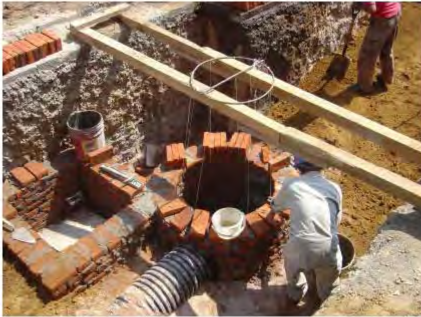
Figura 13. Construcción de pozo de vista
