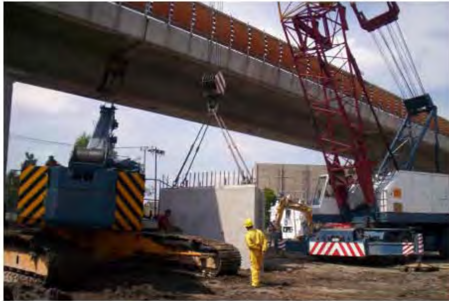
Figura 29. Procedimiento de hincado de muros debajo de la línea del metro
