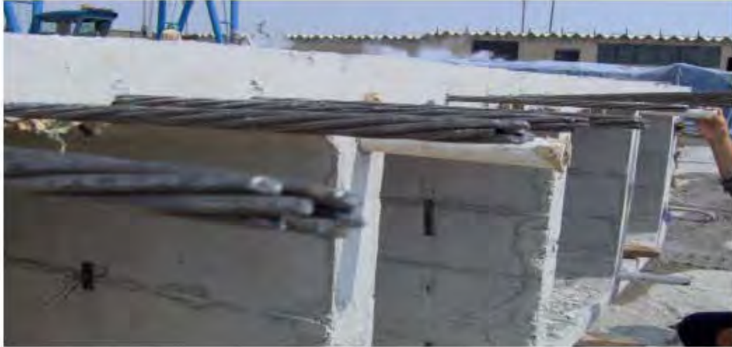
Figura 21. Muro desmoldado con torones cortados.
