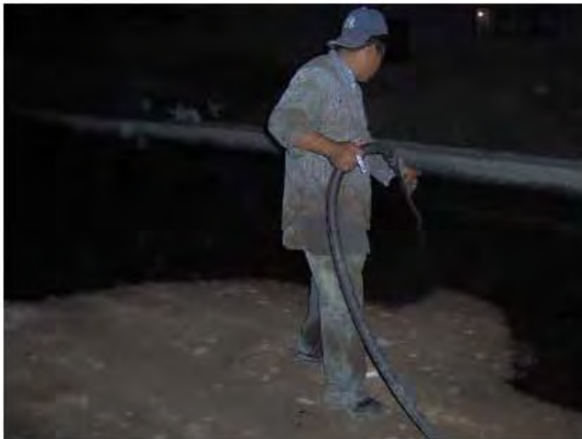
Figura 58. Riego de impregnación
