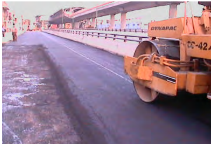
Figura 61. Compactación de carpeta asfáltica.
