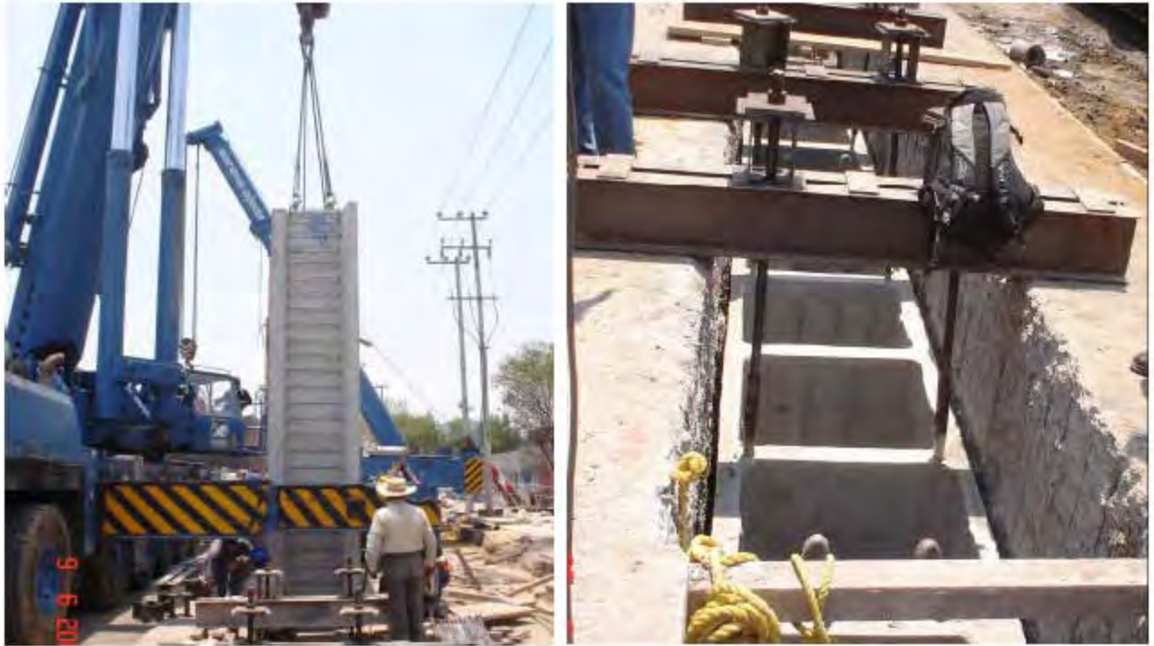
Figura 31. Izq. Hincado de muro prefabricado. Der. Nivelación del muro prefabricado.
