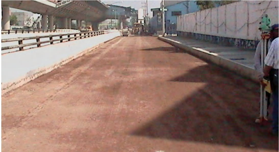
Figura 57. Base compactada.
