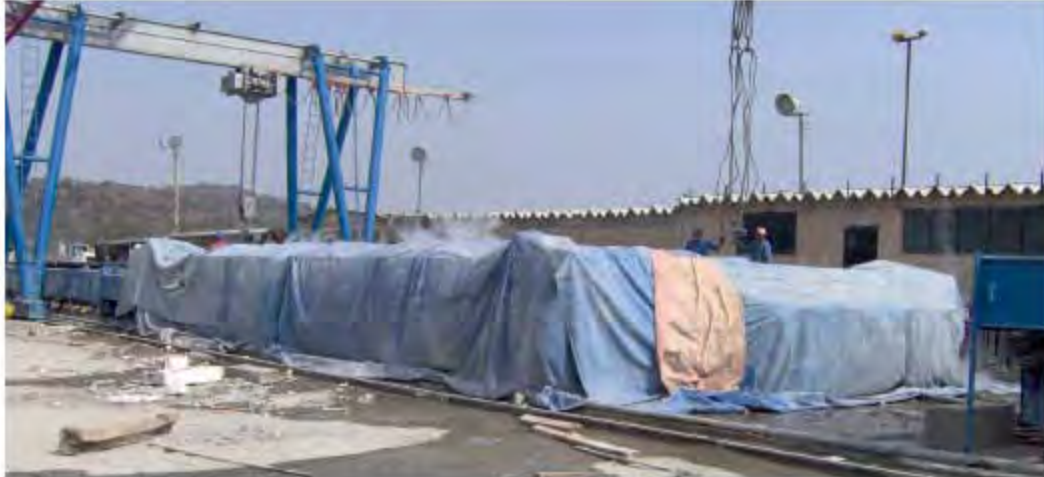
Figura 20. Curado con vapor de un muro.
