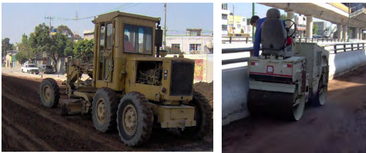
Figura 55. Izq Motoconformadora tendiendo material para base. Der Compactación de base.
