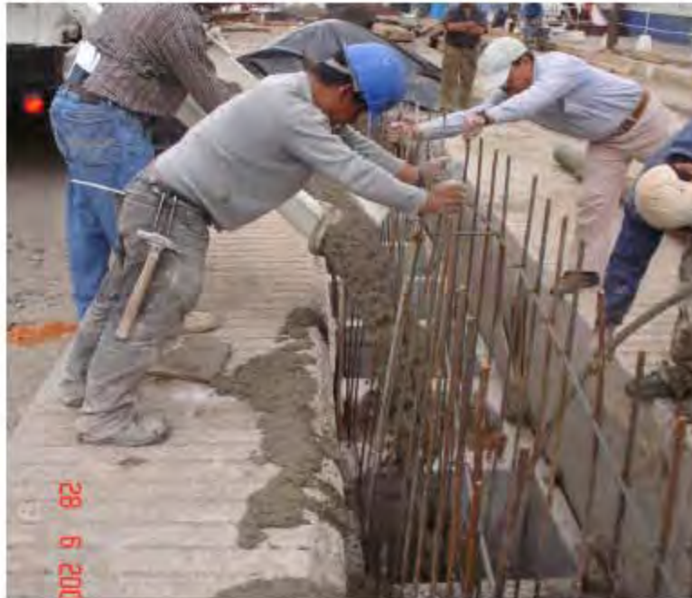
Figura 49. Colado de huecos de muros con canalón.
