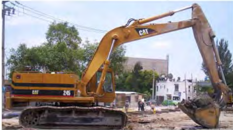
Figura 26. Retroexcavadora con extensión para la excavación de trinchera para muros.
