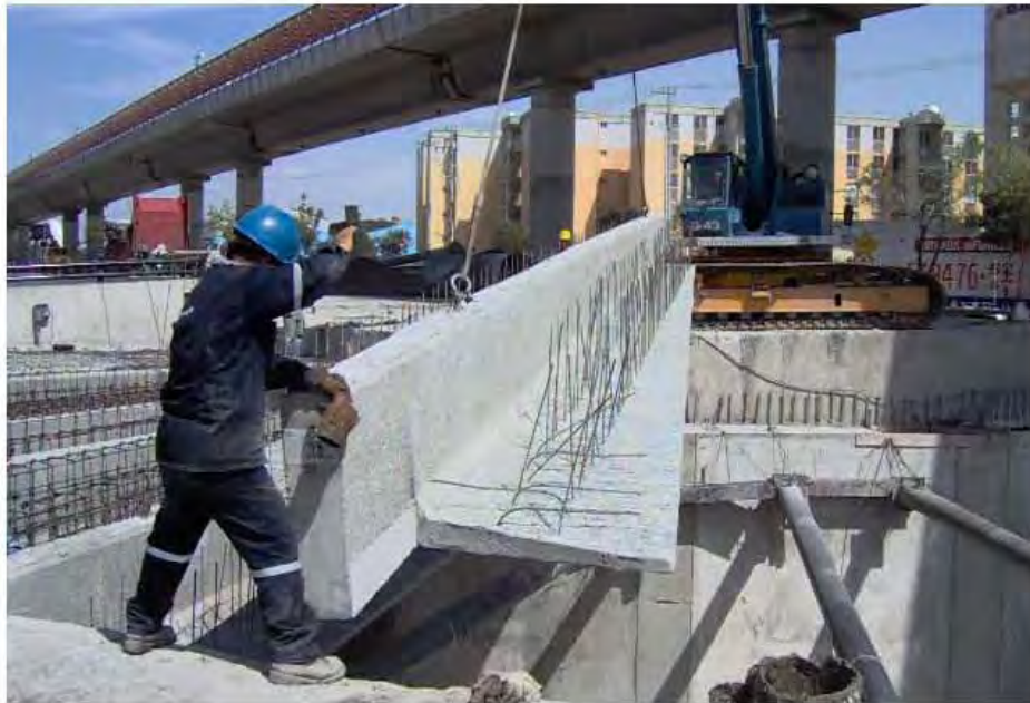
Figura 43. Colocación de tabletas para la losa tapa.
