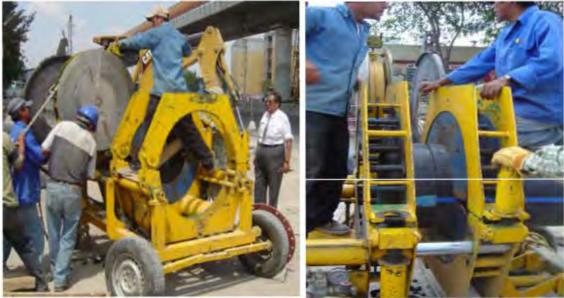
Figura 4. IZQ carro nivelador; DER: Termofusión para tubería de agua potable
