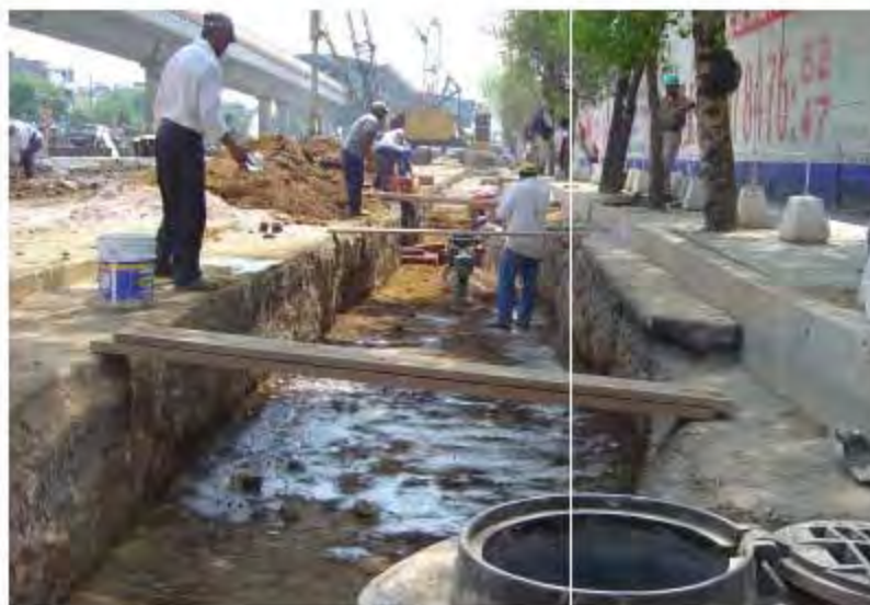
Figura 15. Compactación con pizon vibrante
