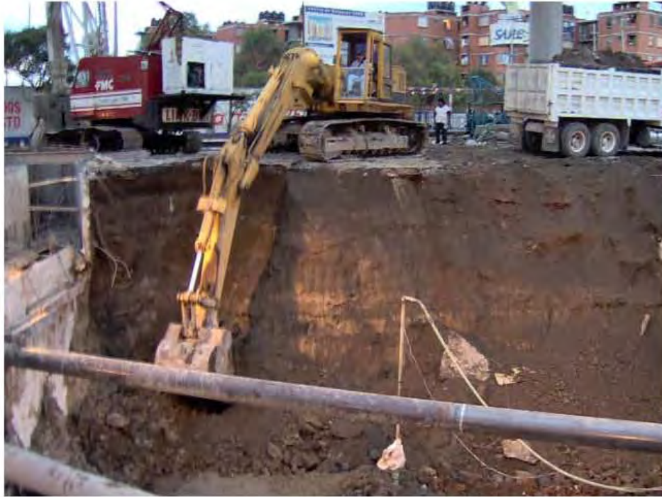
Figura 36. Excavación del núcleo del deprimido.
