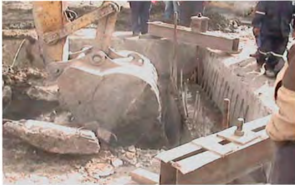
Figura 68. Excavación del núcleo del cárcamo y sujeción de muros.
