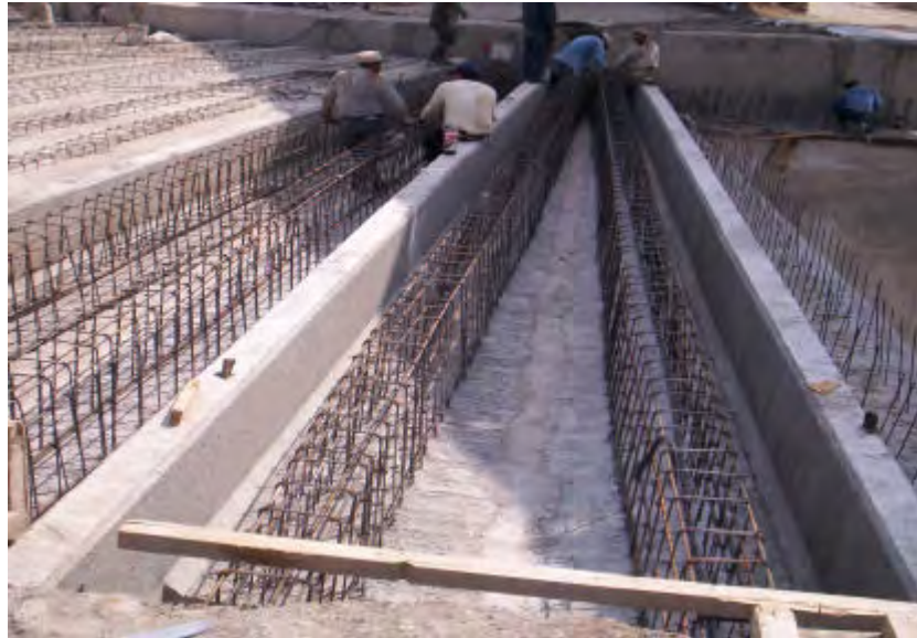
Figura 44. Armado del acero de losa tapa.
