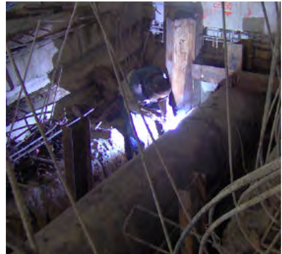
Figura 72. Izq. Arreglo de perfiles para el hincado de tubería, Der. Unión del segundo tramo de tubería con soldadura de arco eléctrico.
