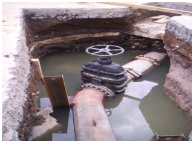
Figura 7. Desvío de la tubería de A. P.
