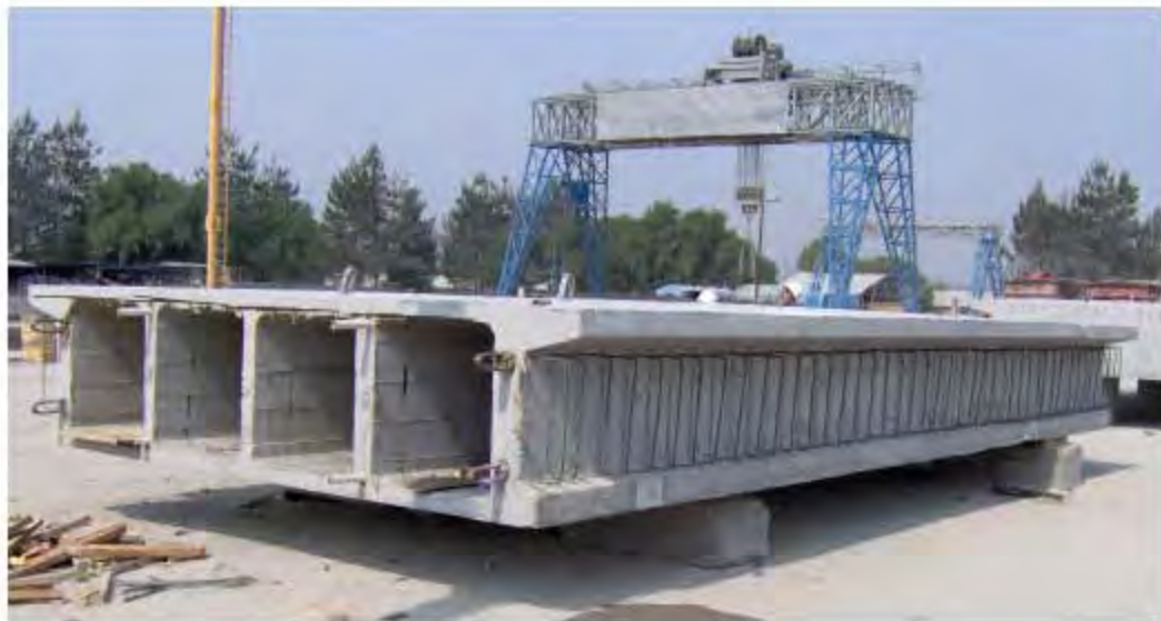
Figura 22. Muro prefabricado terminado.
