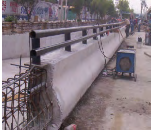
Figura 47. Izq. Colocación del parapeto Der. Detalles de armado de guarnición.
