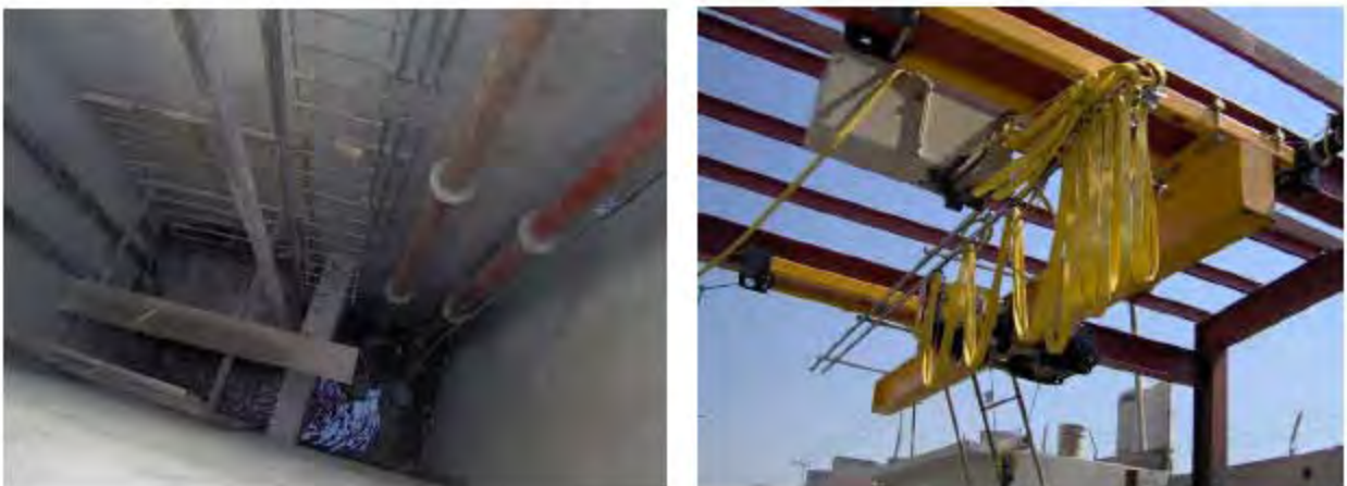
Figura 70. Izq. Colocación de tubería para bombeo Der. Grúa viajera.
