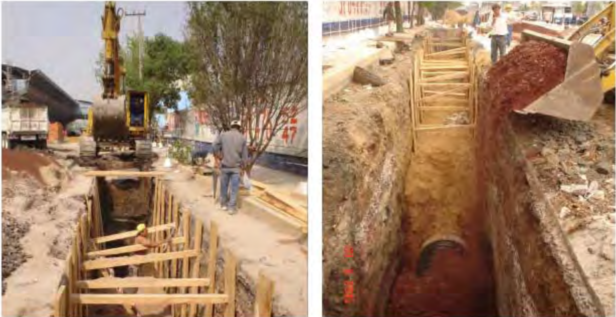
Figura 9. IZQ. Troquelamiento de excavación. DER. Colocación de cama de arena
