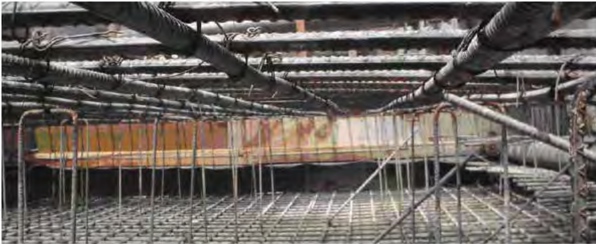
Figura 53. Armado de la losa de fondo, al fondo cimbra con banda de PVC.
