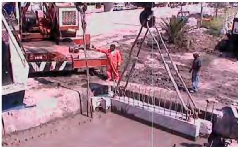
Figura 66. Hincado de muro y nivel de lodo bentonítico.
