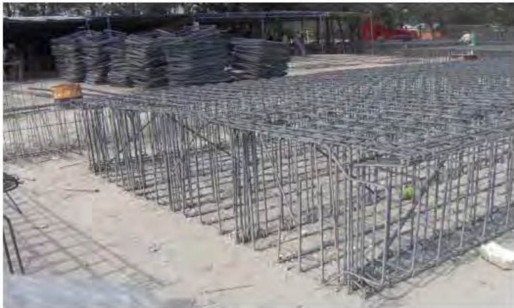
Figura 16. Habilitado del acero para muro.
