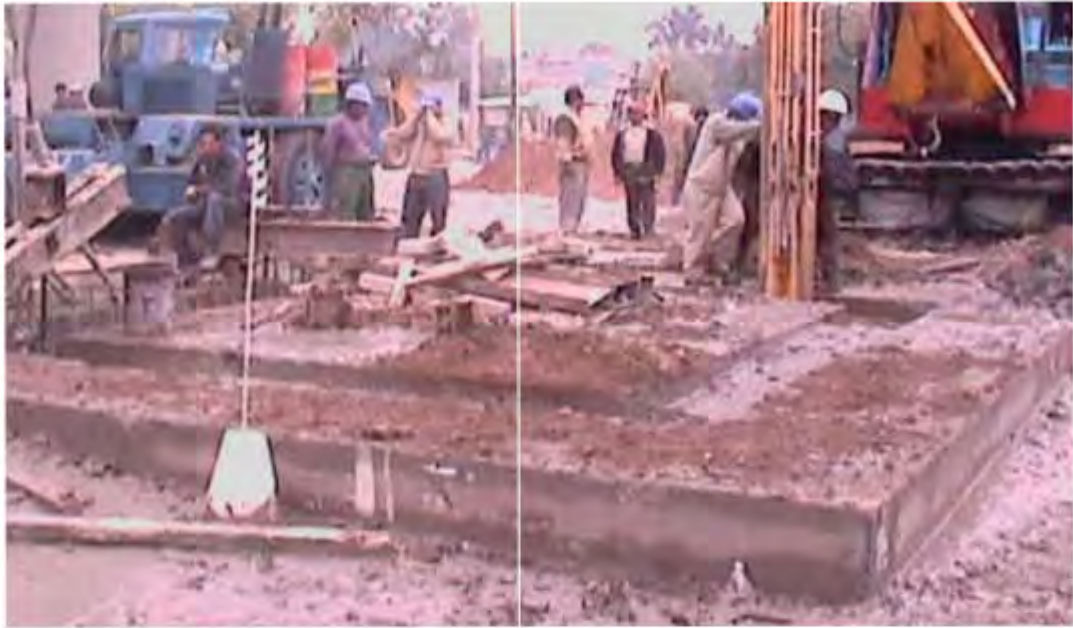
Figura 63. Excavación de trinchera para cárcamo de bombeo.
