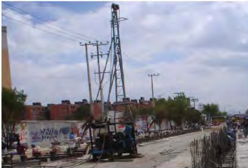
Figura 34. Perforación de pozos de bombeo.
