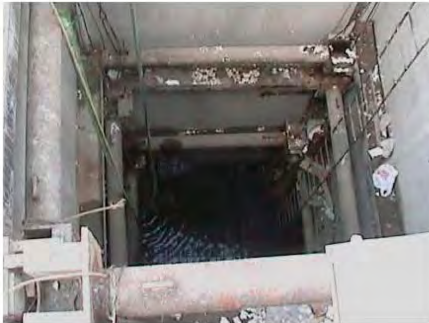
Figura 69. Troquelamiento de muros de carcomo de bombeo.
