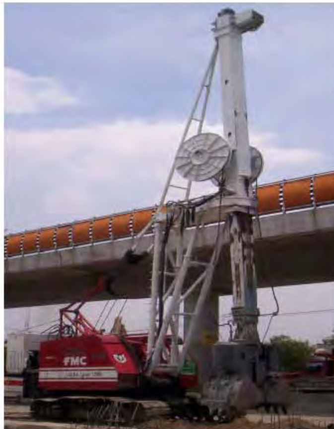
Figura 25. Equipo Link Belt para excavación de zanja.
