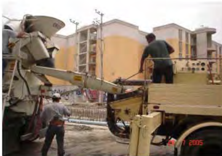
Figura 48. Colado de lastre con bomba para concreto.
