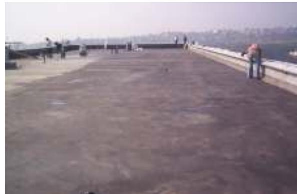
Este tipo de tela lleva un recubrimiento por ambos lados con asfalto modificado a.p.p. (polipropileno atáctico), con un contenido del 25% en volumen, terminado en la parte inferior con una película antiadherente de polietileno y terminado en la cara superior con
