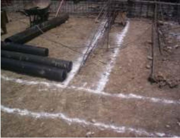
Toda obra de ingeniería civil inicia con la reproducción sobre la superficie del terreno (mediante la aplicación de la topografía) de los distintos trazos dados en los planos del proyecto, empezando con la planta general que es donde se ubican el o los edificios que forman dicho proyecto.
