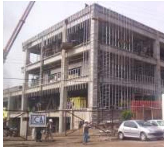
2. Posteriormente se empezó con la colocación de los paneles, que en este caso fueron del tipo PANEL DENS GLASS GOLD, el cual es un panel de yeso, ideal para exteriores, es de importación y esta hecho con silicón y malla de fibra de vidrio. Para la
