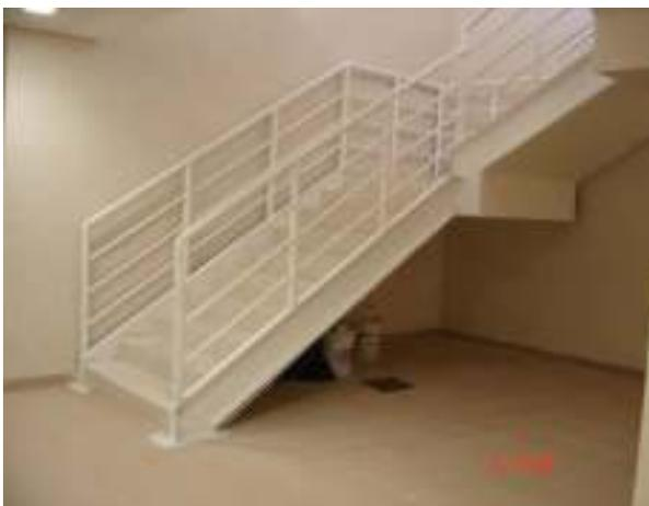
*Los escalones* también son de concreto reforzado con  $f'c=200 \text{ kg/cm}^2$ , con agregado máximo de 19 mm, con acero de refuerzo del No.3 a cada 20 cm en ambos sentidos y soldadas al fierro ángulo. El espesor es de 5.62 cm, con 30 cm de ancho por 140 cm de largo, colados en sitio con acabado rugoso y recubiertos por una placa de mármol sin pulir de 2 cm de
