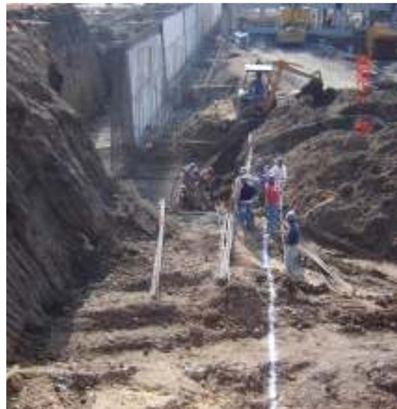
Para este proyecto la excavación se realizó utilizando maquinaria para construcción pesada como fue el caso de las retroexcavadoras, utilizadas para excavar y retirar el material, así como góndolas para llevar el material producto de la excavación al banco de tiro el cual se ubica en el Bordo de Xochiaca y fue el que asignó el Gobierno del Distrito Federal.
