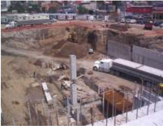
periodo de ejecución muy corto como fue el caso de este proyecto. Los caminos de acceso se encuentran a ambos lados de la estructura (oriente y poniente), y para su construcción se utilizaron retroexcavadoras, camiones de volteo y compactadores vibratorios para evitar su deterioro en época de lluvias.
