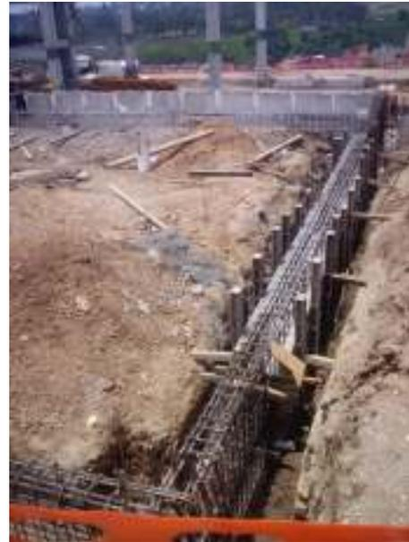
Con lo anterior se garantizó que las pilas de cimentación se apoyaran en el limo poco arcilloso con arena fina y media de consistencia muy dura que se detectó en todos los sondeos realizados.
