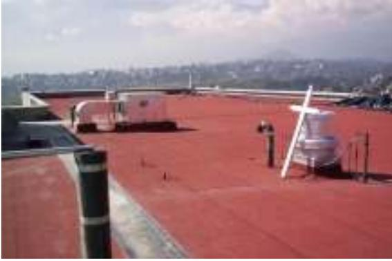
acabado aparente granular integrado de importación, esmaltado al horno, integrado en color rojo terracota e indicado para usarse en climas fríos a templados.
