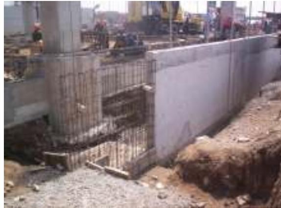
muro de contención se utilizaba cimbra metálica especial, de 2.30 m de altura.
