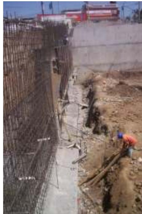
También se dejó preparado el apoyo para las escaleras de emergencia que quedan en la parte externa del edificio, para ello se unieron las pilas con las contratraves para que al momento de colocar los perfiles estructurales de las escaleras se hiciera un colado que fuera monolítico.
