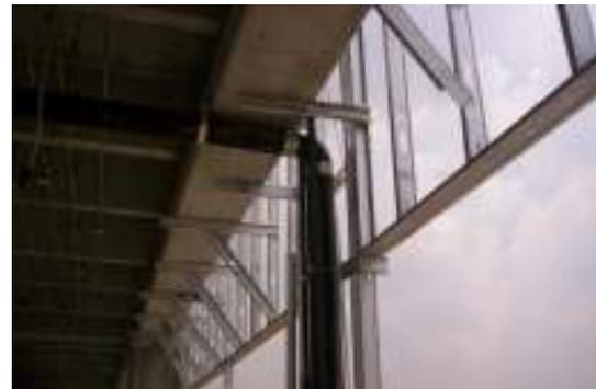
colocación de los paneles en las partes altas del edificio se utilizó una GRUA LINK BELT para el izaje, aunque su colocación fue manual y se fijó a la estructura de acero galvanizado con tornillería de acero inoxidable.
