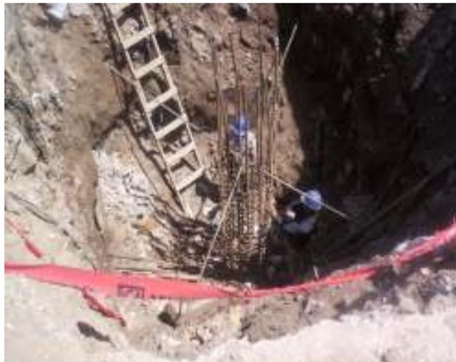
Para lograr una adecuada transmisión de elementos mecánicos en la cimentación se utilizaron contratraves de sección rectangular de 40 x 150 cm con un  $f'c=350$  kg/cm<sup>2</sup>, con
