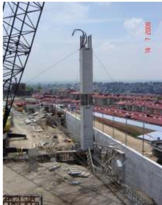
5. En su posición y verticalidad se procedió al colado del dado de la cimentación, para tal efecto se empleó concreto clase 1 de resistencia rápida  $f'_c=300 \text{ kg/cm}^2$ . Los cables tensores se retiraban a las 24 hr posteriores al colado pero sólo si el concreto del dado había adquirido una resistencia inicial  $f'_{ci}=80 \text{ kg/cm}^2$ .
