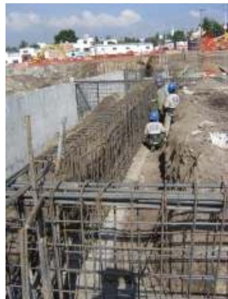
detalladamente la colocación del acero de refuerzo. Las varillas que se ocuparon fueron desde el No. 3 hasta el No. 10, con un límite de fluencia  $f_y=4200 \text{ kg/cm}^2$ , ligando en algunas partes las contratraves, columnas, así como el muro de contención a las pilas de cimentación con el fin de que la losa fuera monolítica y tuviera un mejor trabajo estructural.
