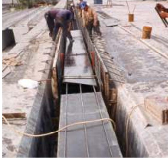
fresco y permitir el desmolde de la pieza sin daños. Los de plástico no se deberán de usar cuando se anticipen temperaturas superiores a los 60 °C. Algunos plásticos son susceptibles a agentes desmoldantes por lo que deberá analizarse la factibilidad de su uso. Cuando se usen moldes de acero se asegurará que no exista corrosión, bordes de soldadura o desajustes en las juntas.
