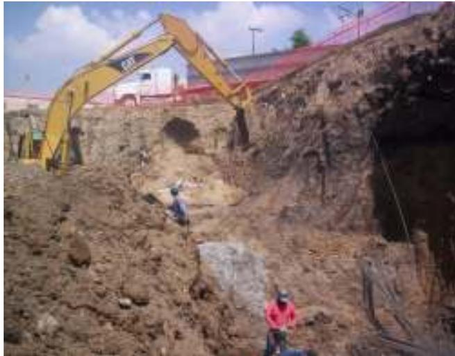
El material no se puede clasificar exactamente, pues fue completamente heterogéneo ya que en el lugar de la construcción se encontraron rellenos de basura de casas habitación así como material producto de la demolición de diversas estructuras provenientes del sismo de 1985, situación por la cual tampoco se pudo reutilizar en ningún caso, enviando así todo el material excavado al banco de tiro.
