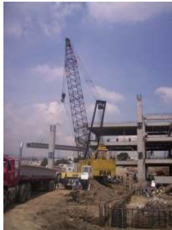
3. Para realizar el montaje de manera más sencilla, la grúa se colocaba al centro del claro con áreas libres de maniobra tratando de quedar a 90 grados con la posición del tráiler que transportaba las losas TT, luego se izaba la pieza y se giraba hasta que llegaba a su posición final.
