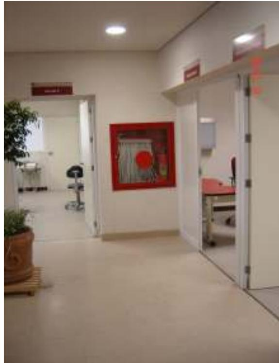
*Piso de vinil asfáltico* de loseta vinílica marca vinylasa, de color true clip 593, con dimensiones de 30.4 x 30.4 cm. x 3.1 mm, asentada con adhesivo especial.
