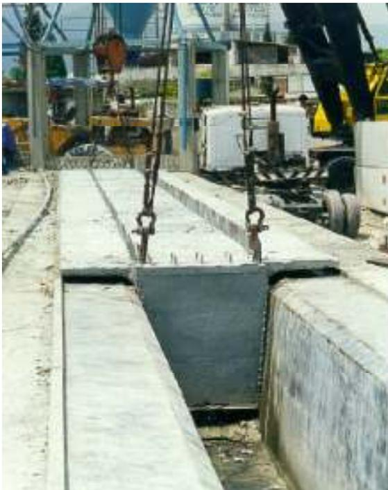
compresión  $f'_{ci}$  necesaria para resistir los esfuerzos debidos a la transferencia del presfuerzo al cortar los cables y liberar a las piezas para su extracción. Generalmente el valor de  $f'_{ci}$  se considera del 70 u 80 por ciento del  $f'_{ci}$  de diseño.
