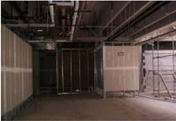
También se usó el muro divisorio de DUROCK de 100, 108, 150 y 300 mm, el cual también se colocó sobre placas fijadas con tornillos autorroscantes a cada 30 cm perimetralmente y a cada 60 cm de separación en refuerzos intermedios, fijados al bastidor (refuerzo) construido a base de canales y postes de lamina
