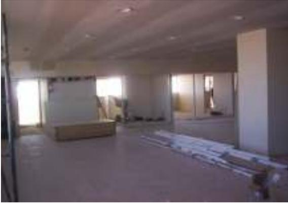
El falso plafón está apoyado en placas con estructura metálica sujeta con colgantes de alambre galvanizado del No.12 a cada 90 cm, fijos a la losa. La canaleta de carga es de lámina galvanizada de calibre No.20 a cada 90 cm, sujeta con un listón metálico y fijada con tornillo autorroscante a cada 30 cm a la losa.
