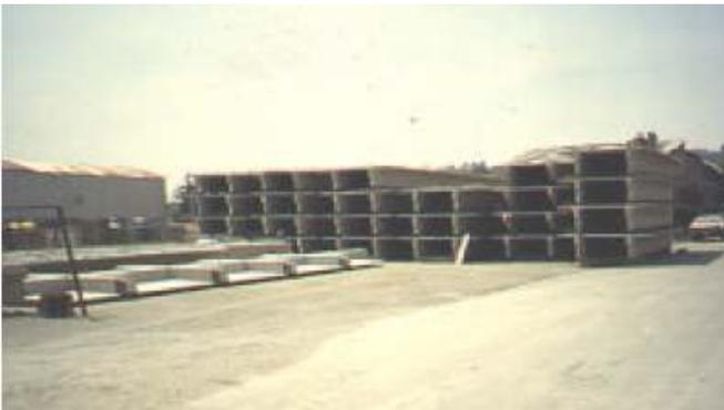
Un elemento deberá almacenarse soportado únicamente en dos apoyos localizados en o cerca de los puntos usados para el izaje y manejo de la pieza.
