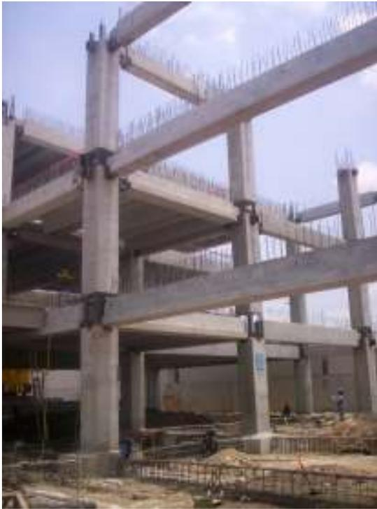
La estructura está formada mediante marcos rígidos. Las columnas son de concreto reforzado y las trabes de concreto presforzado. El sistema de piso es a base de losas TT presforzadas. Existen además colados en sitio como son las pilas de cimentación, las trabes de liga, losas sobre el terreno natural, entre otros.
