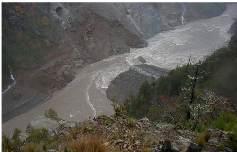
Imagen 8. 1 Falla asociada a filtración de flujo, presa Ralco, Chile.
