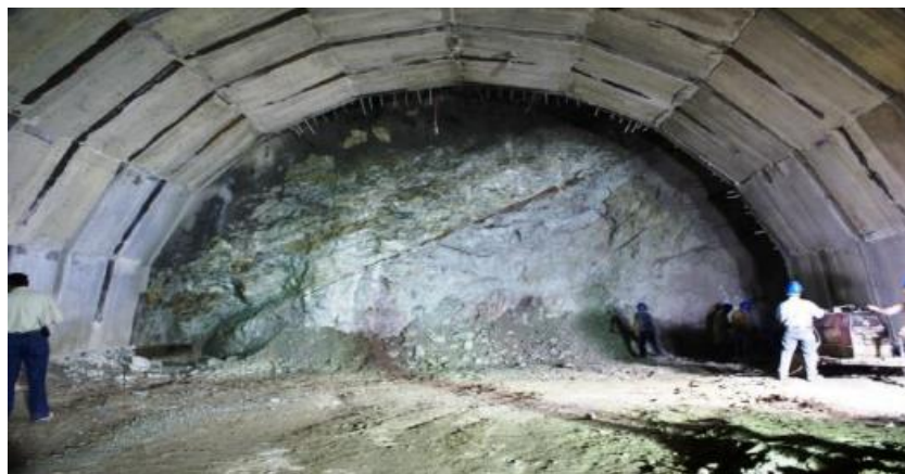
Imagen 4. 3 Frente de excavación del túnel uno en la presa La Yesca.
