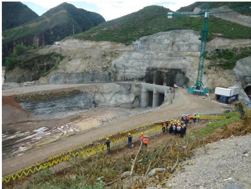
Figura 6. 3 Portales de entrada de túneles de desvío en el río Magdalena, Colombia.
