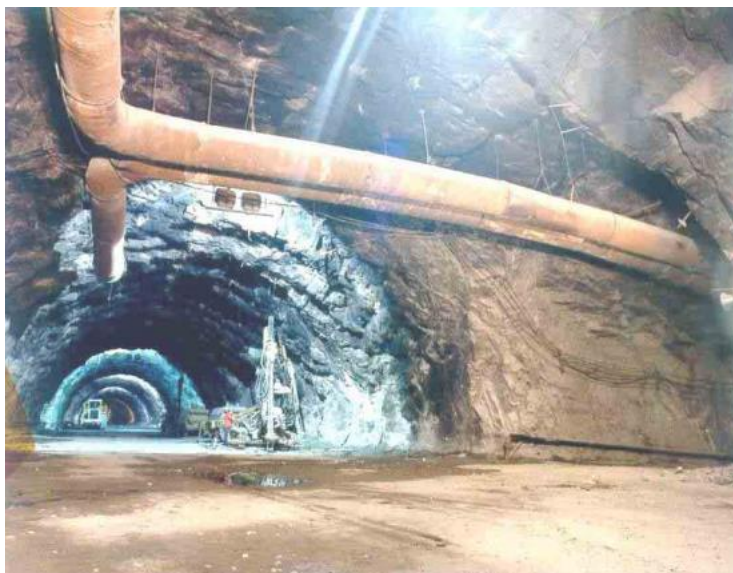
Imagen 4. 1 Media sección del túnel de desvío y bifurcación hacia el túnel crucero en la presa El Cajón.
