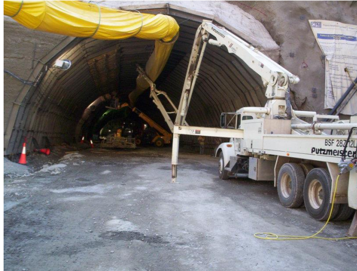
Figura 6. 4 Excavación de túnel de desvío en la presa La Yesca.
