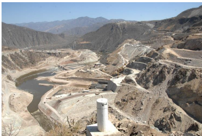
Figura 8. 1 Caminos de acceso a la presa La Yesca, Nayarit, México.
