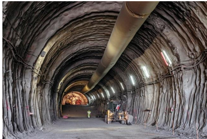
Figura 8. 4 Construcción de túnel de desvío.
