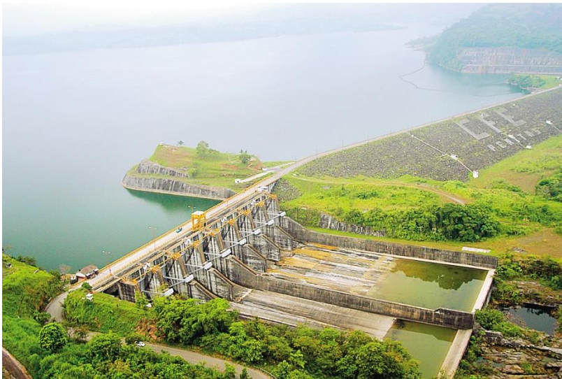
Imagen 3. 2 Obra de excedencia en la presa Peñitas, Chiapas, México.
