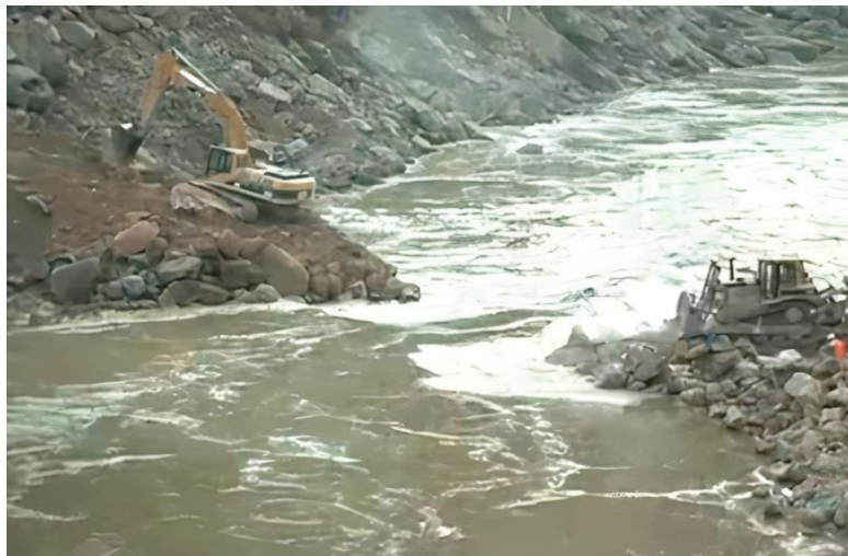
Figura 6. 9 Cierre parcial del río Sogamoso, Colombia.
