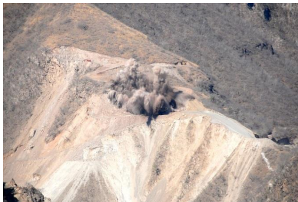
Figura 8. 3 Voladura en la presa La Yesca.
