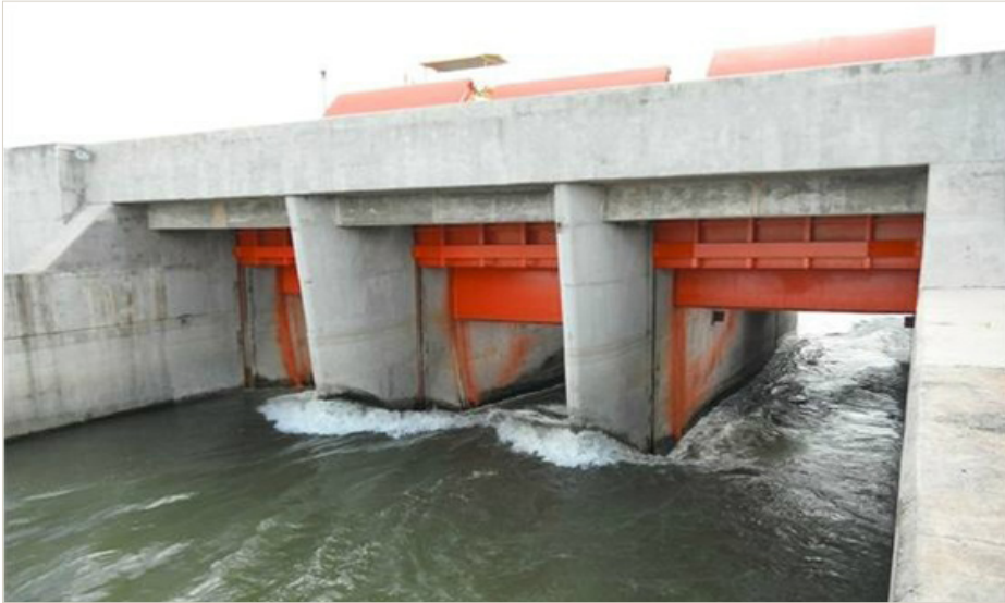
Figura 3.3 Efectos de las pilas en las características del flujo
