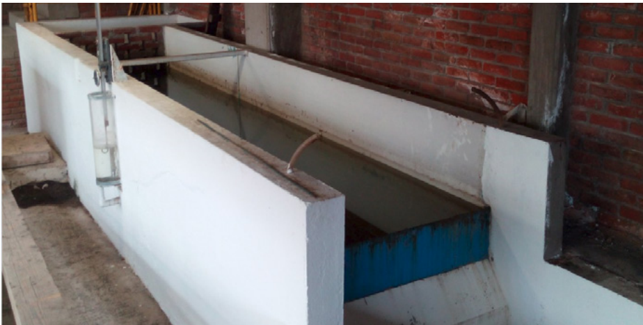
Figura 3.7 Canal de acceso, vertedor y limnómetro utilizados para aforar
