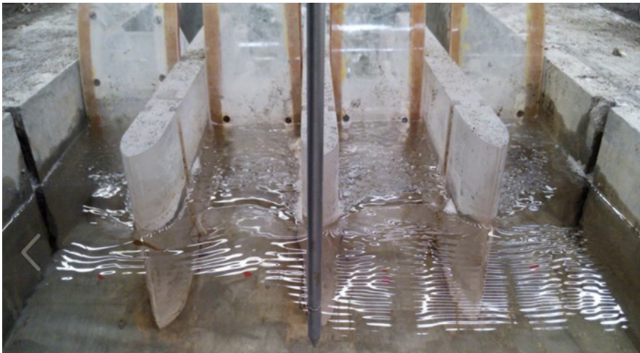
Figura 4.4 Sitio de medición del tirante y_p en el canal de la margen derecha
