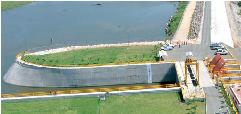
Figura 3.2b Escala para leer H_p en el canal de la margen derecha
