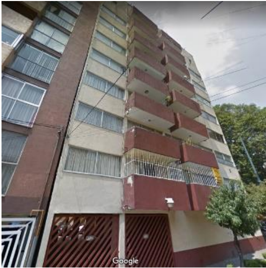
a) Antes del sismo, modificada de Google Earth, (2017)
