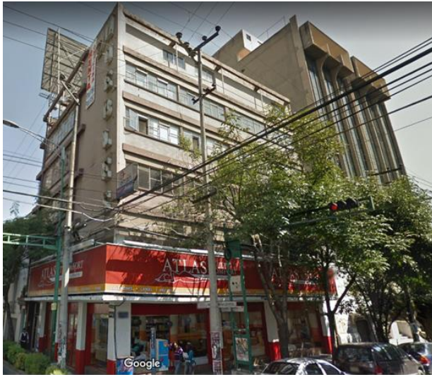
a) Antes del sismo, modificada de Google Earth, (2017)
