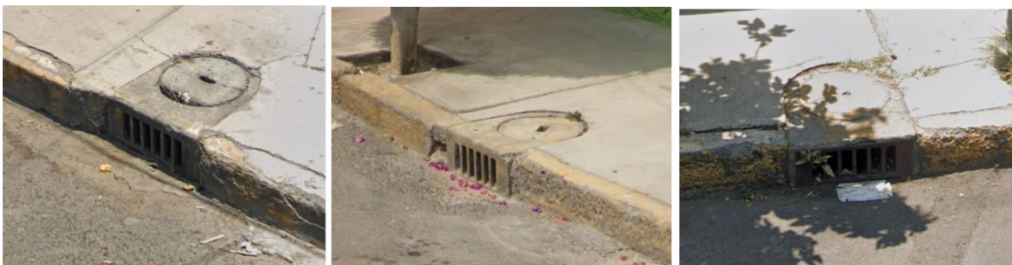
Figura 22. Fotografías de algunas coladeras de banqueta de la cuenca de estudio
