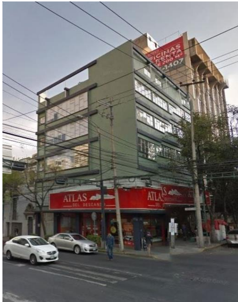
a) Antes del sismo
