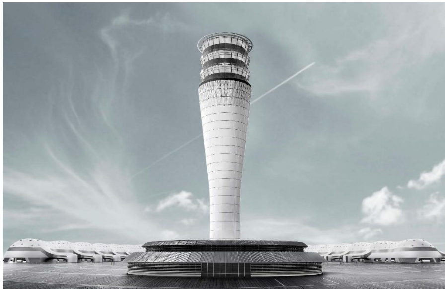
Imagen 48 Torre de Control NAICM
