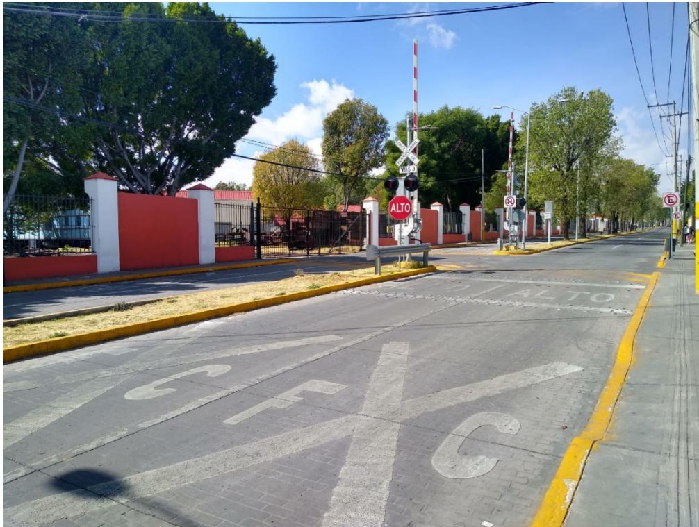
Fotografía 1. Cruce a nivel Tipo A correctamente señalizado.
