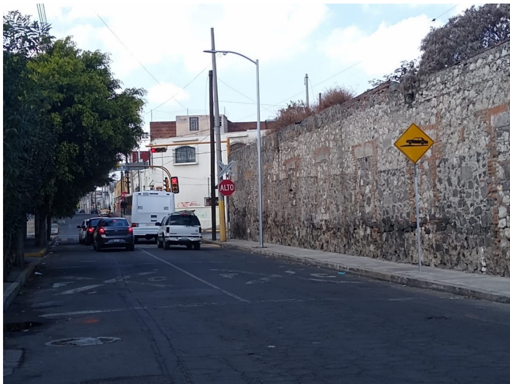
Fotografía 4. Desgaste en el señalamiento.
