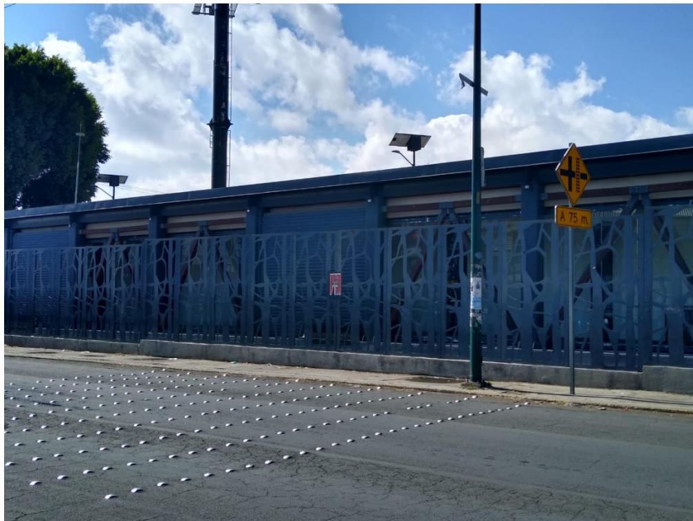
Fotografía 6. Presencia de señalamiento horizontal y zona de vibradores.
