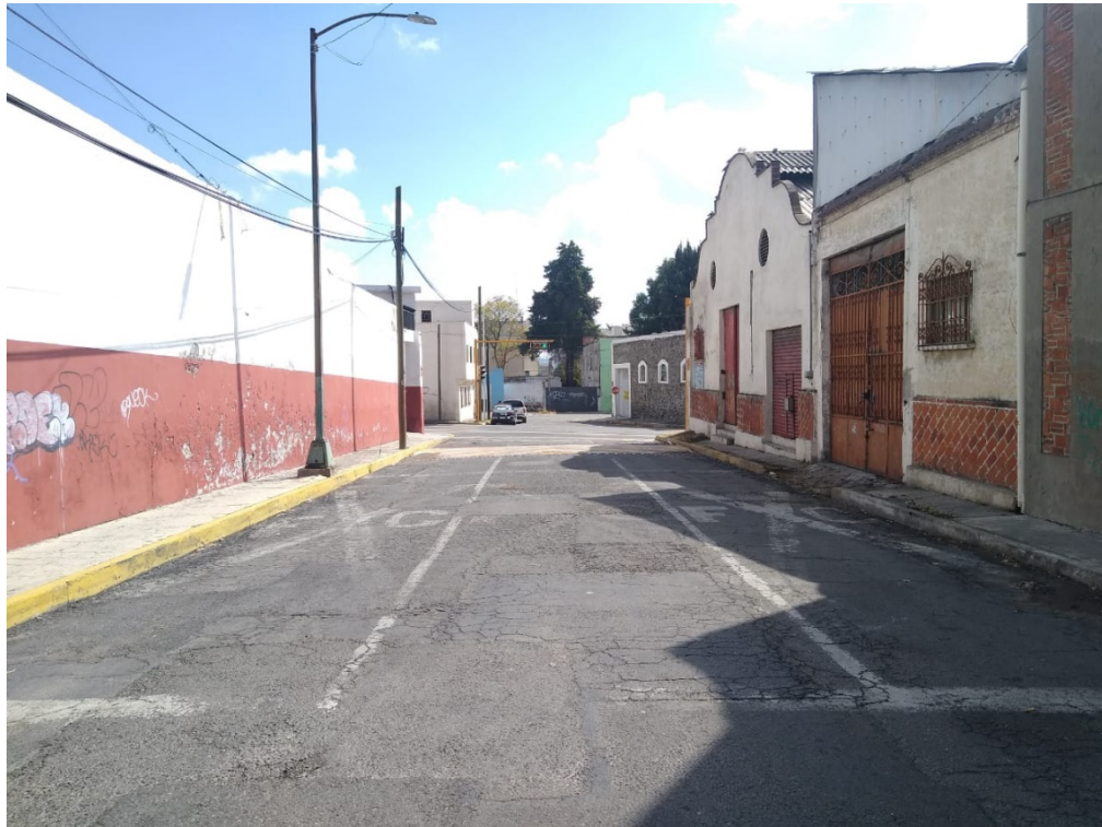
Fotografía 3. Cruce a nivel con desgaste en señalamiento y ausencia del mismo.
