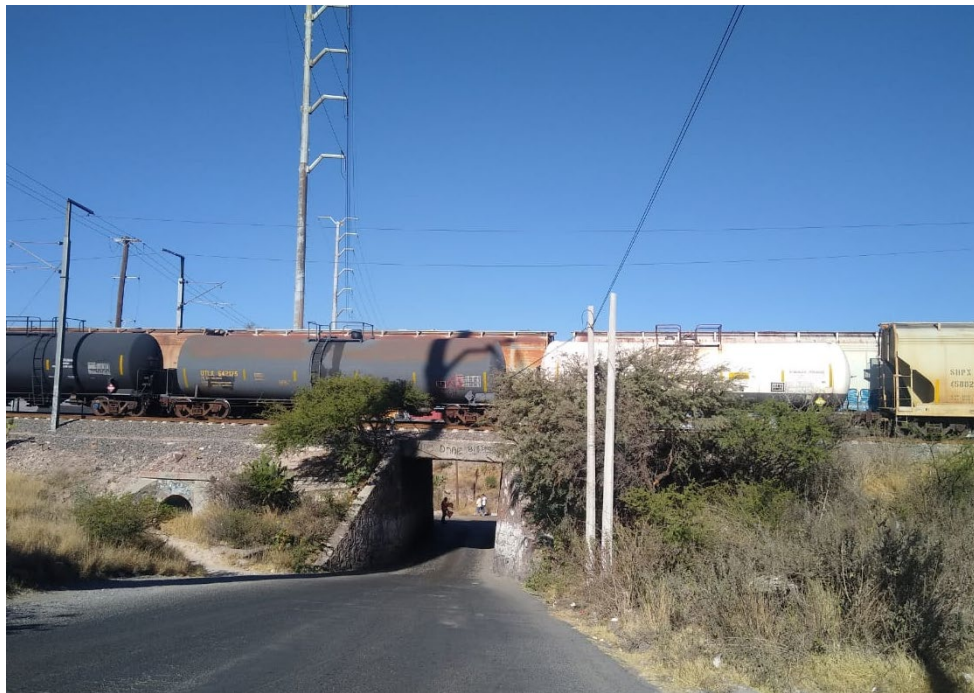
Figura 7. Paso inferior de ferrocarril. Fuente: Elaboración propia.
