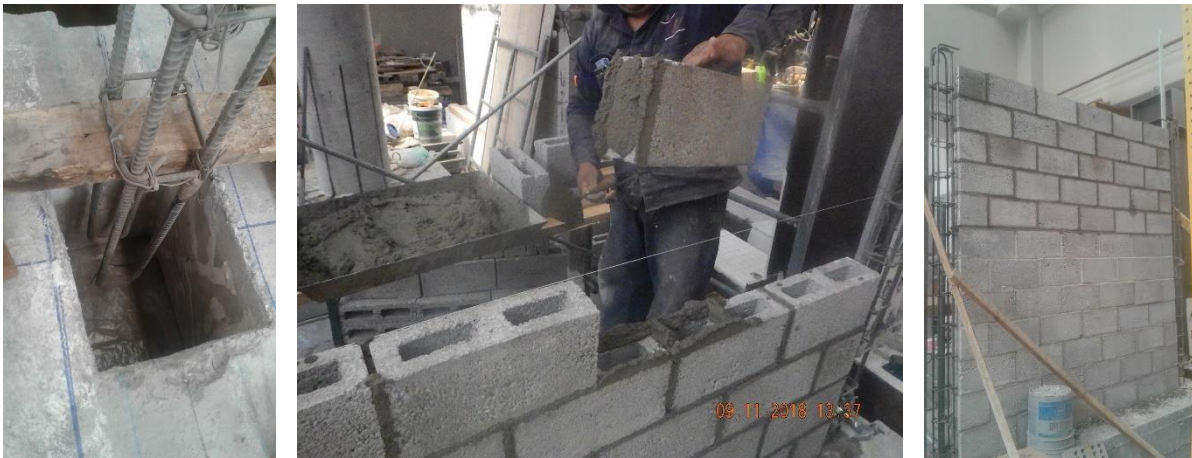
Figura 4.1 Proceso de construcción (castillos y tablero)
