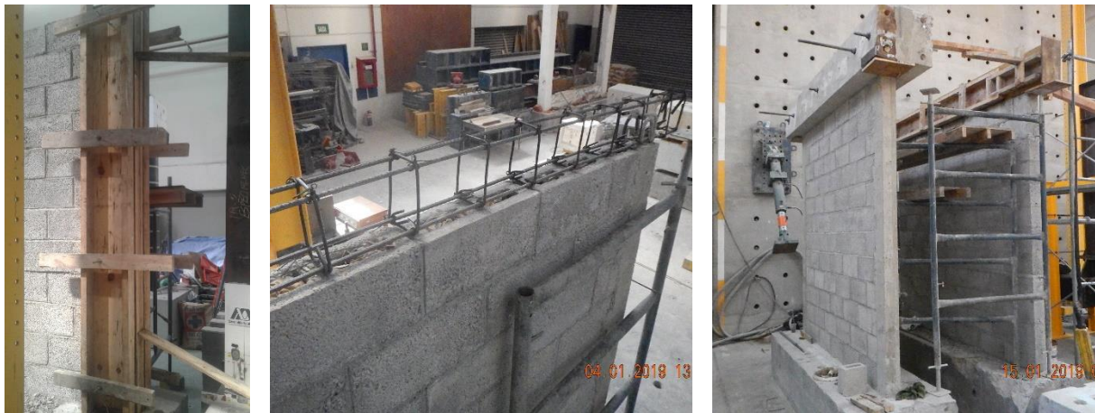
Figura 4.2 Proceso de construcción (dala y montaje)
