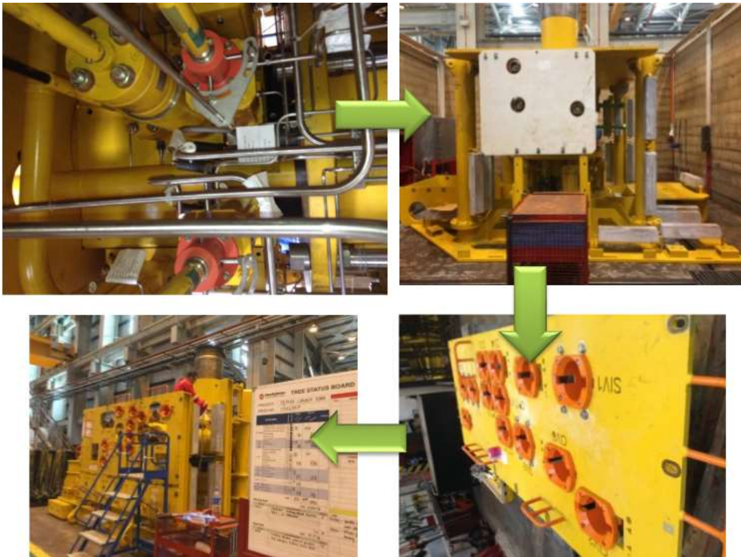
Figura 4.14 Instalación de líneas hidráulicas 59
