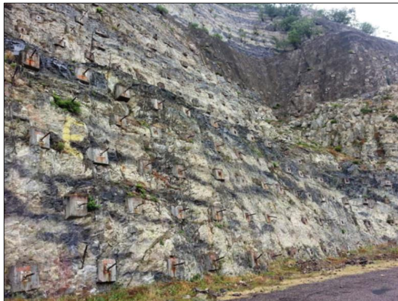
Fotografía 3.1 Talud de la obra de toma, se observa la secuencia de brecha volcánica con la andesita (CFE, 2016).
