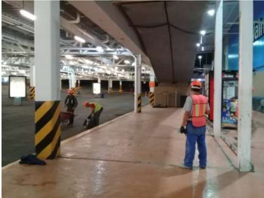
Fotografía 1.- Estacionamiento Planta Baja.
