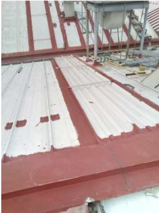
Fotografía 2.- Techumbre. Sellado de láminas.
