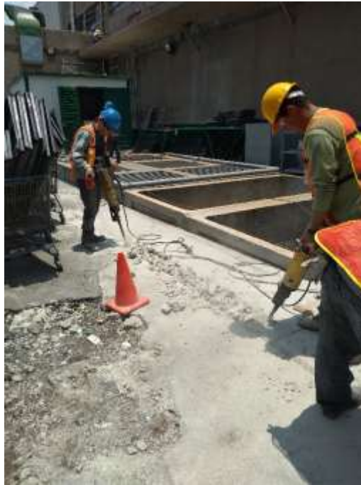
Fotografía 18.- Adecuación de la planta de tratamiento.
