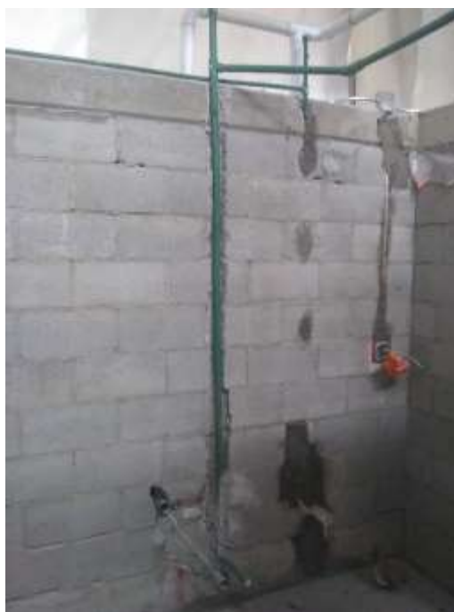
Fotografía 12.- Instalación hidrosanitaria del retrete.
