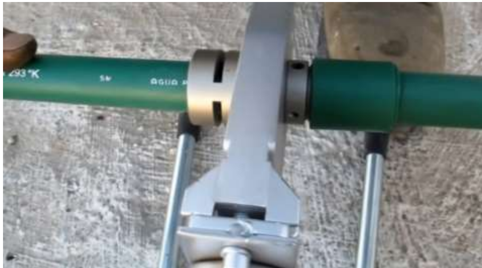
Fotografía 4.- Proceso de termofusión.
