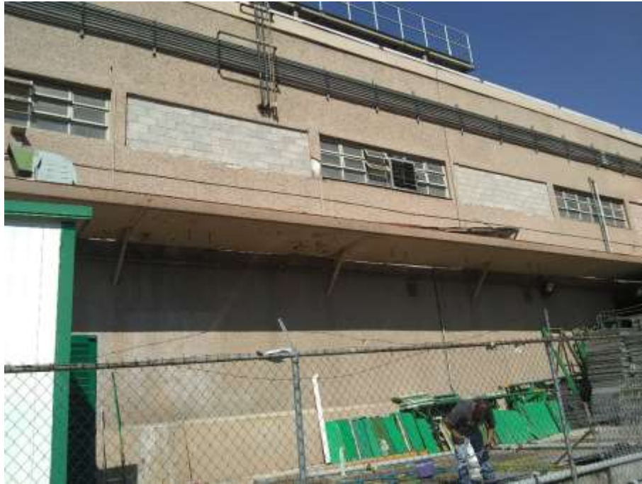
Fotografía 8.- Planta de tratamiento. Fachada posterior.
