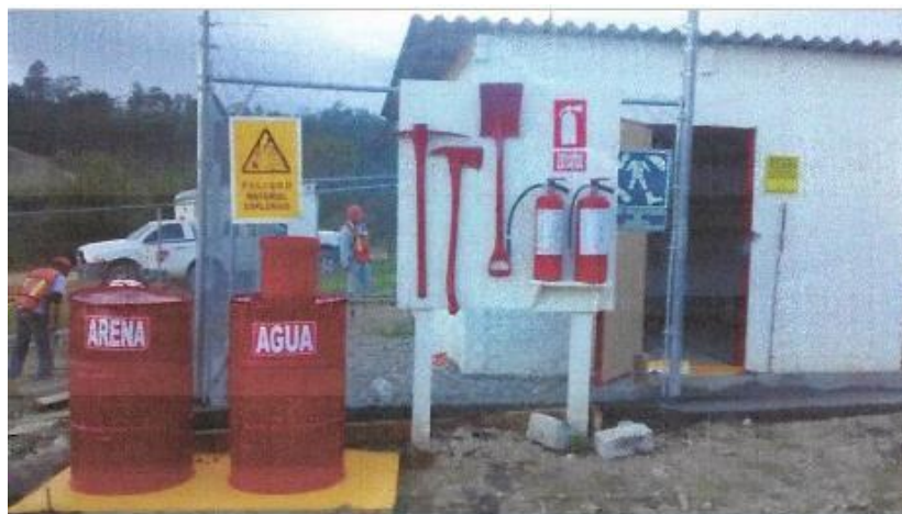
Fuente: Aguilera, E. (2015). Fotografía. Tablero de control contra conato de incendio al exterior de los polvorines. México.
