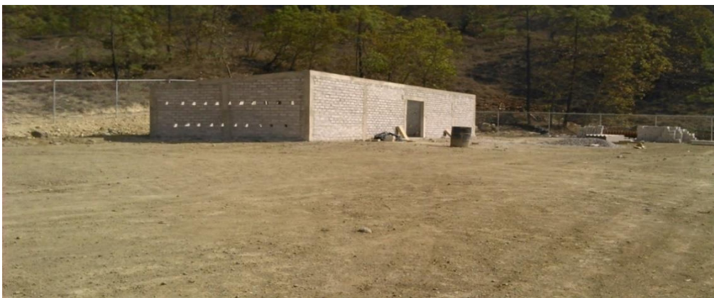
Fotografía 3. Muros de block para la construcción de polvorines.
