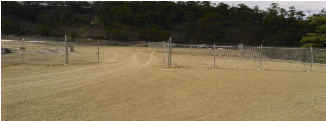
Fotografía 8. Cerca perimetral del predio donde se encuentran los polvorines.
