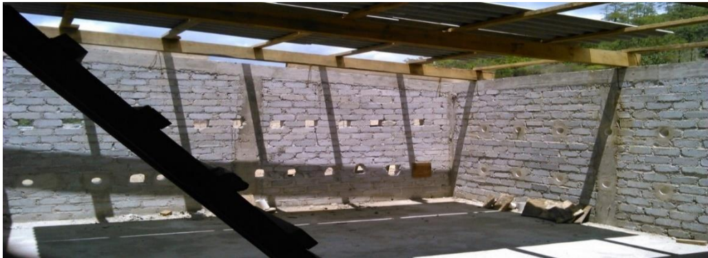
Fotografía 4. Soportes de madera para el techo.
