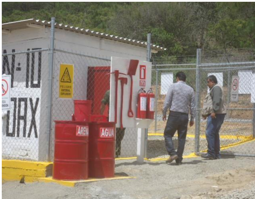
Fuente: Aguilera, E. (2015). Fotografía. Inspección militar de los nuevos polvorines. México.
