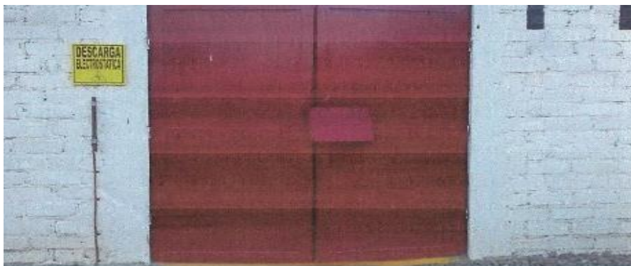
Fotografía 10. Puerta de acero forrada en su cara interior de madera.
