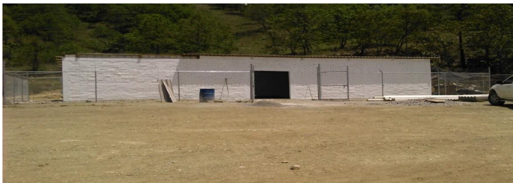
Fotografía 7. Cerca perimetral de cada polvorín.
