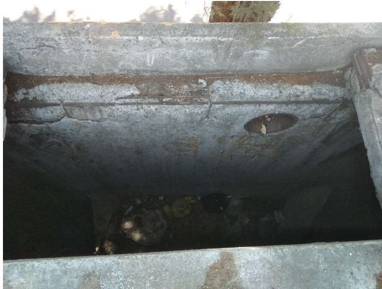
Figura II-7 Vista de una de las paredes interiores del tanque
