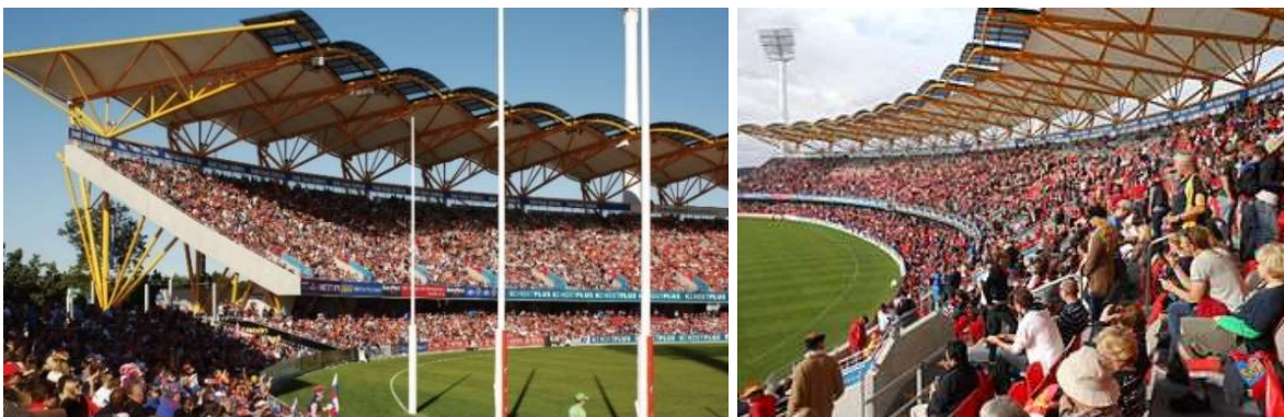
Figuras 5.4 y 5.5 – Ejemplo del caso de un estadio con gradas en cantiléver con espectadores. Metricon Stadium, Australia. [Carney, 2019].
