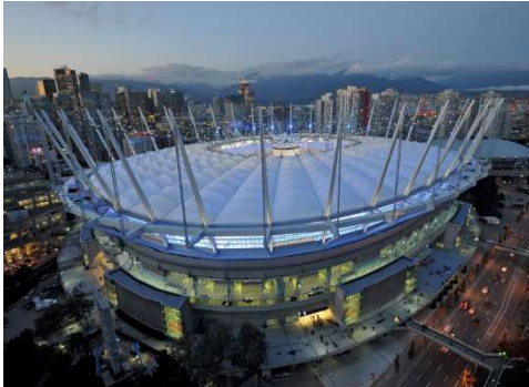
Figura 5.6 – Fotografía del BC Stadium en Vancouver, Canadá. [GENIVAR and Geiger Engineers, 2012]
