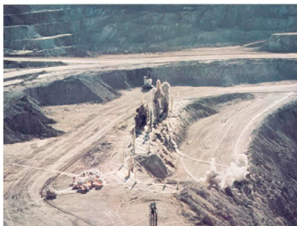
Figura 18.9. Voladura en un tajo a cielo abierto.
