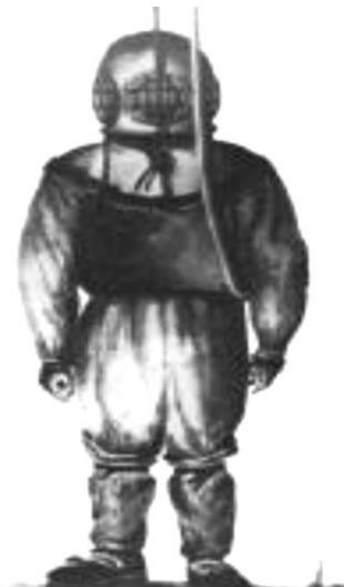
Figura 3.6 Traje para bucear diseñado en el año de 1837 por Augustus Siebe. [7]
