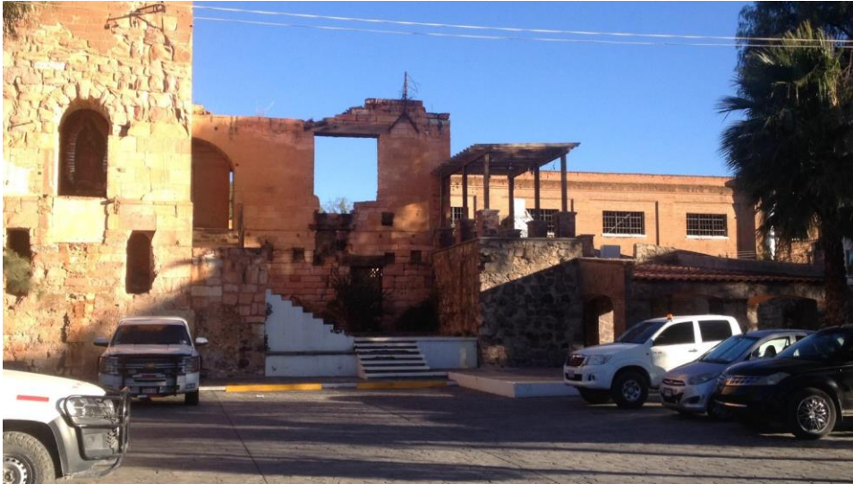
Fig. 8. Vista reciente en la Hacienda Proaño. La hacienda aún conserva algunas instalaciones construidas en la primera mitad del siglo XIX. Fotografía tomada en enero del 2019.
