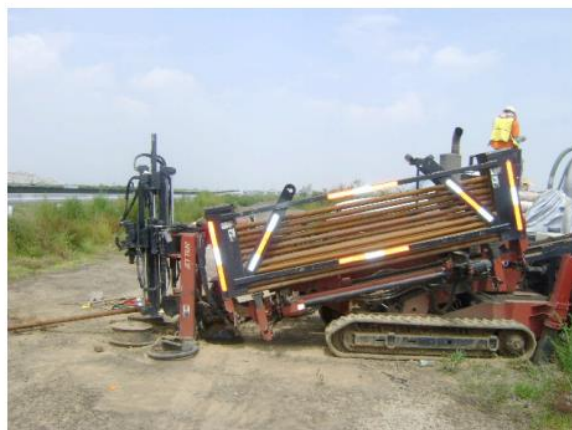
Ilustración 16.1 Máquina de perforación horizontal empleada para colocar los inclinómetros horizontales en campo.
