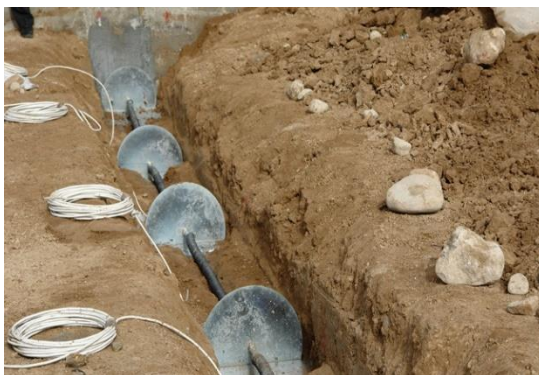
Ilustración 39. Extensómetro interno de placa, proceso de instalación en zanjas. Tomado de SISGEO.COM
