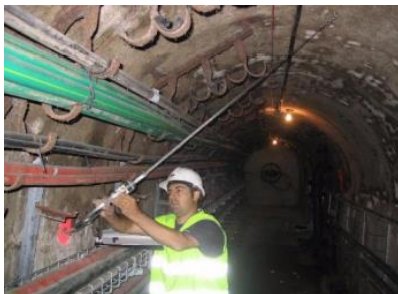
Ilustración 37. Mediciones con cinta de convergencia en túnel (Vall González, 2016)
