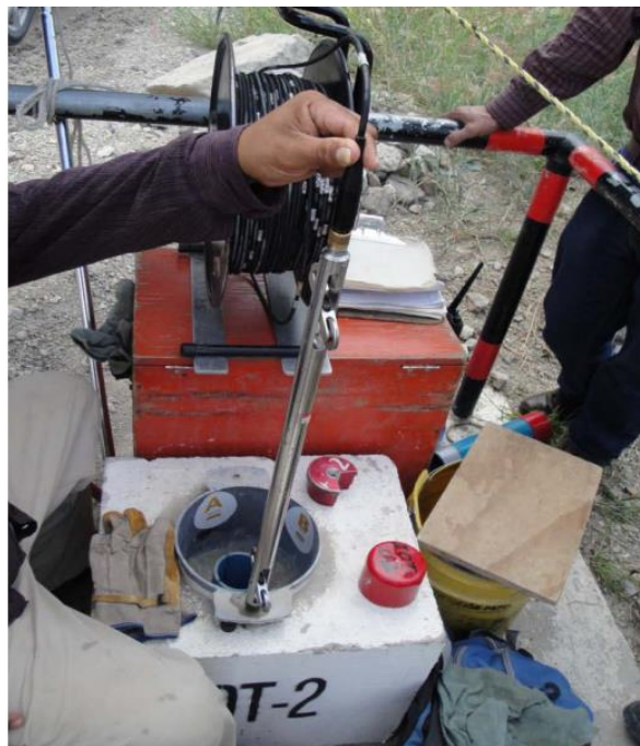
Ilustración 6. Operación en campo de sonda para inclinómetro vertical.
