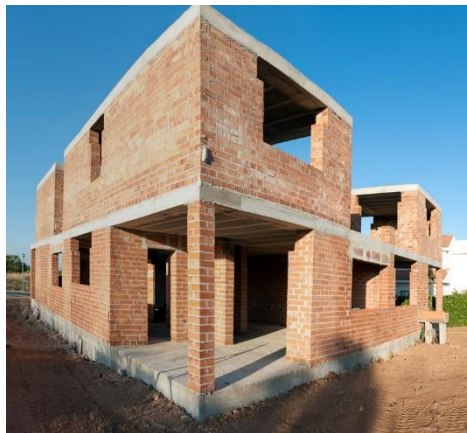
Figura 1. Construcción de una estructura de mampostería simple (Mahajan, 2016).
