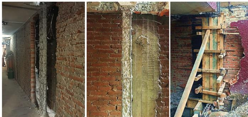
Figura 17. Reparación de elementos de confinamiento (Archivo fotográfico proyecto ConTex, 2018)
