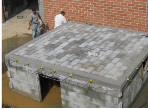
Figura 4. Sistema de mampostería postensada (Bonett, 2014).
