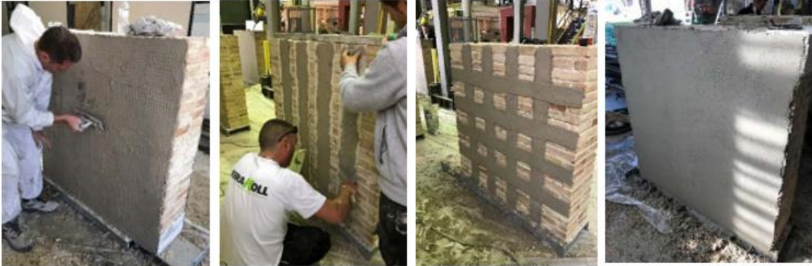
Figura 60. Configuraciones de colocación del encamisado textil. (García, 2020)
