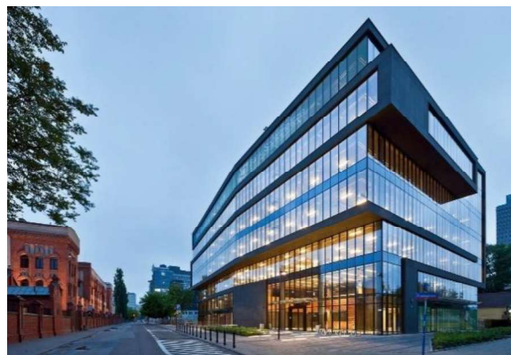
Figura 28: Ejemplo de edificio de oficina, Grzybowska, Polonia.
