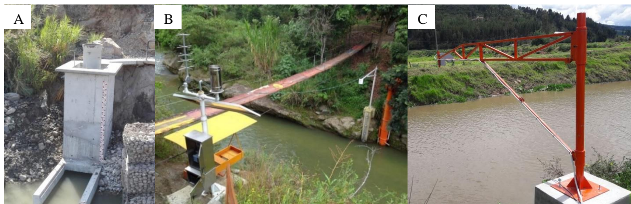
Figura 7. Tipos de estaciones hidrométricas. Estación con limnómetro (A), estación con cable colgante (B) y estación con sensor (C)
