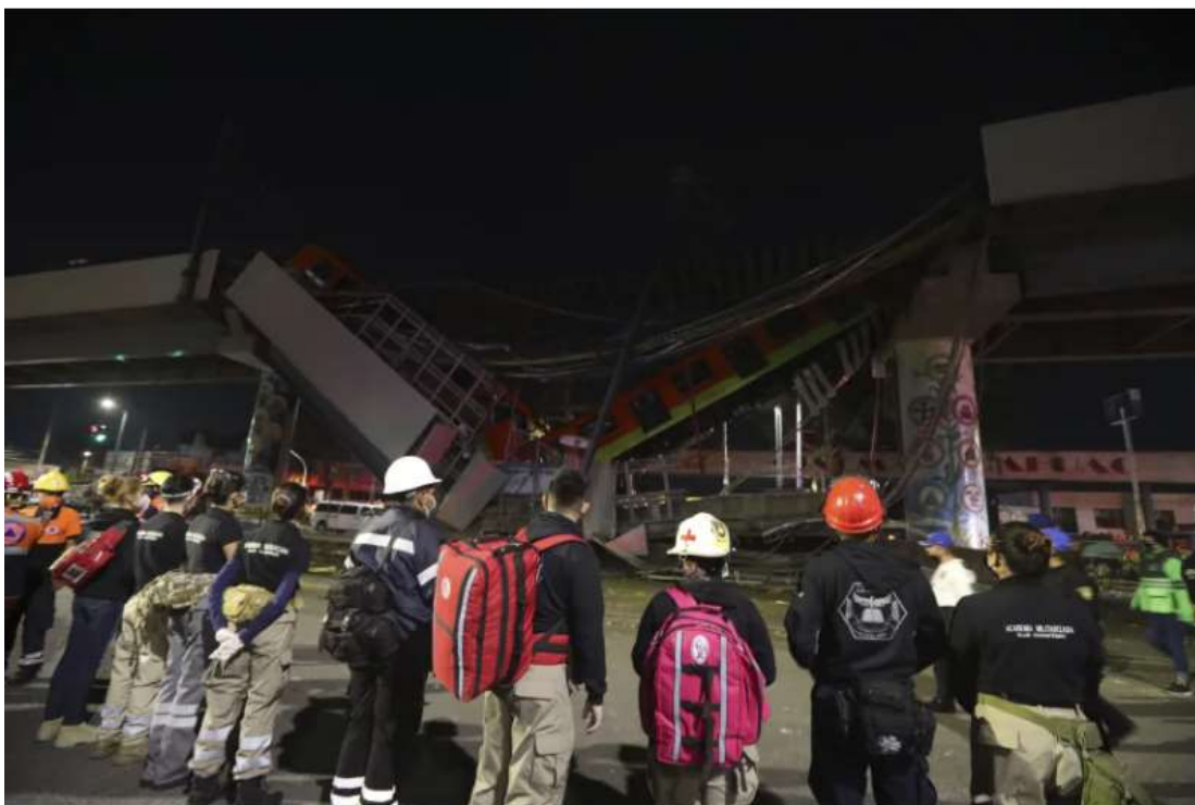
Figura 1.- Colapso de la línea 12 del Metro de la Ciudad de México . (AP Foto/Marco Ugarte)
