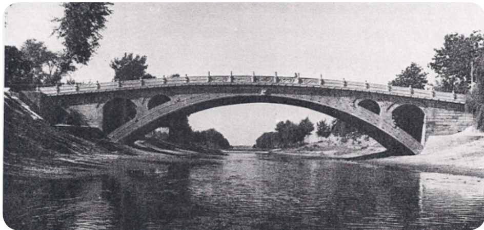
Figura 2.2 El Gran Puente de Piedra
