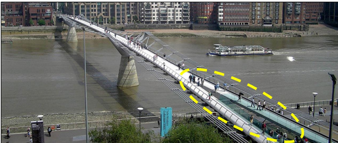
Figura 3. Vista del puente Milenio con extremo sur del puente con plataforma bifurcada ( https://quialondres.es/millenium-bridge ).
