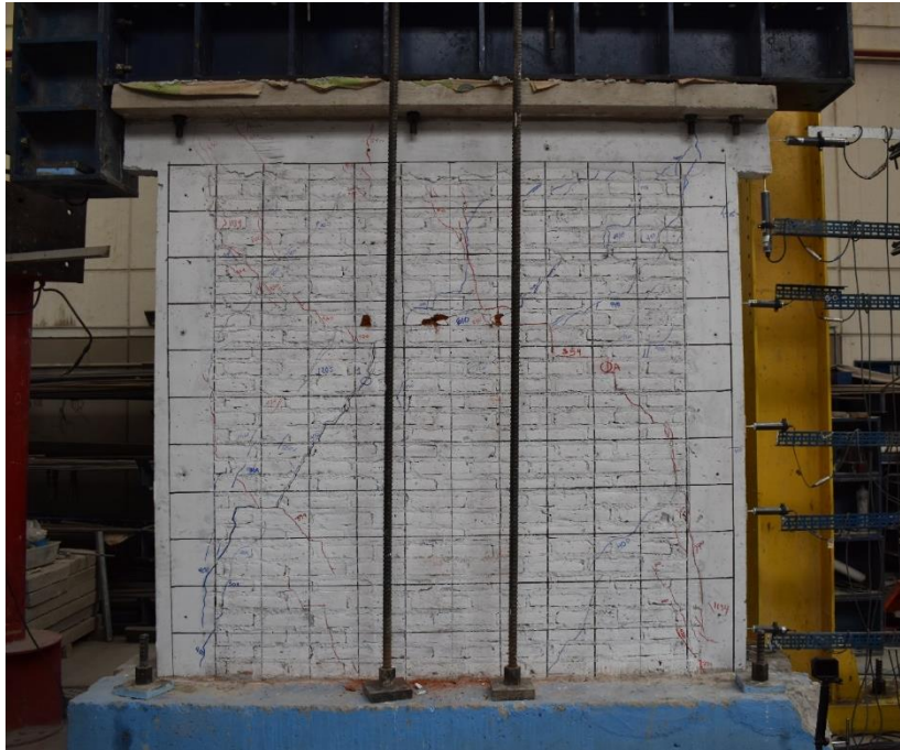
Figura 3.31. Patrón de grietas muro M4.
