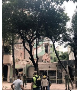
Figura 2.20 Edificio colapsado en Ámsterdam 25.
