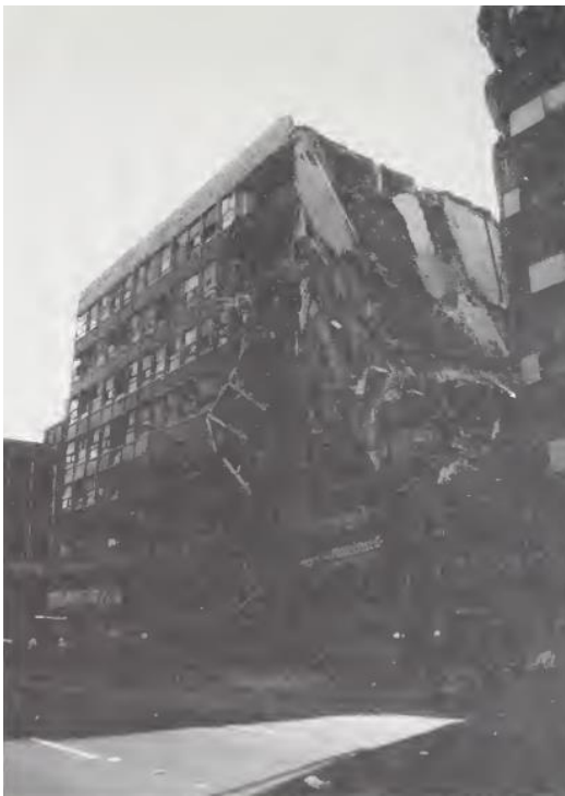
a) Edificio de 7 niveles en la avenida 20 de noviembre que colapsó por golpeteo
