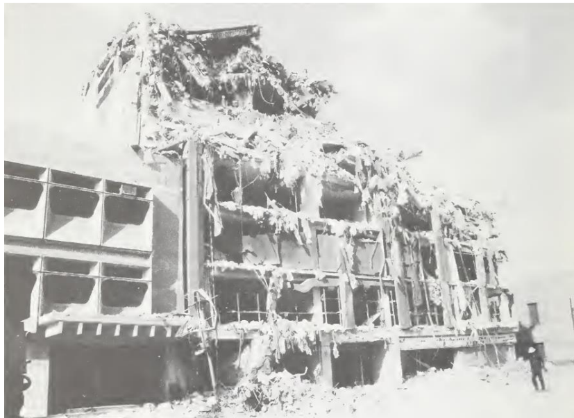
Figura 1.3 Colapso por golpeteo en la Av. José María Izazaga esquina con Isabel la Católica, sismo de 1985. (William & Felix, 1987).
