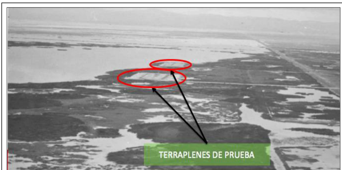
Imagen 1. Fotografía área de los terraplenes de prueba ejecutados.
