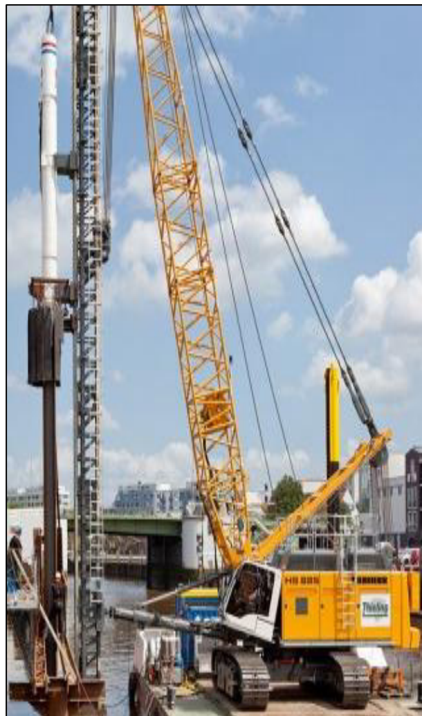
Imagen 7. Martillo para hincado de pilotes
