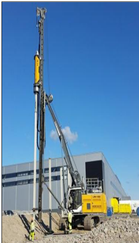
Imagen 6. Equipo de hincado de pilotes
