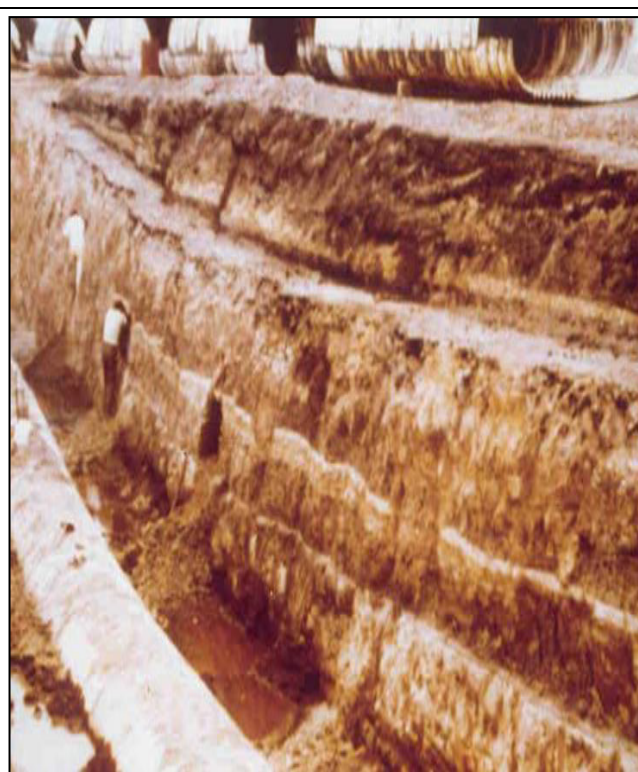
Imagen 17. Monitoreo de terraplenes.
