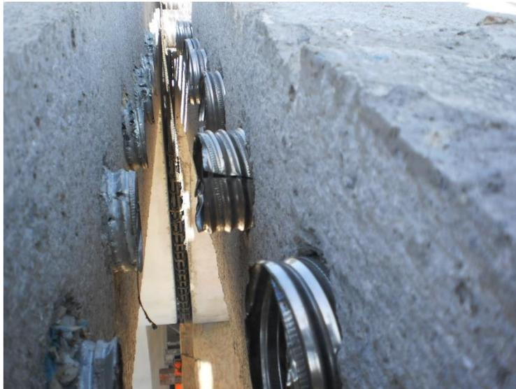
(2) Imagen 7.3 Ductos de presfuerzo. Fuente del autor.
