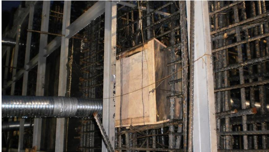
(1) Imagen 6.21 Armado de dovela de pila. Fuente del autor.
