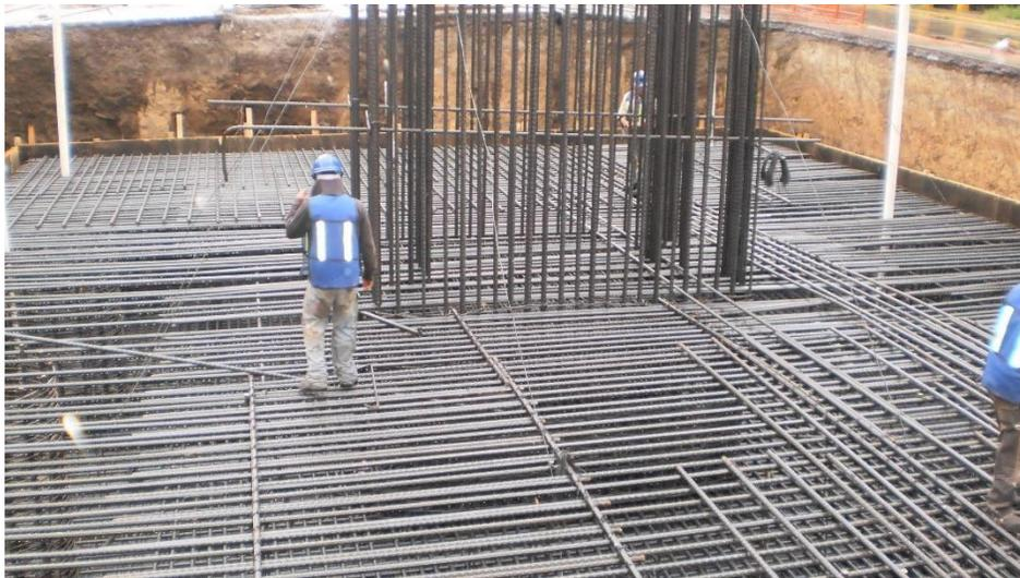
(2) Imagen 4.4 Armado de zapata losa superior. Fuente del autor.
