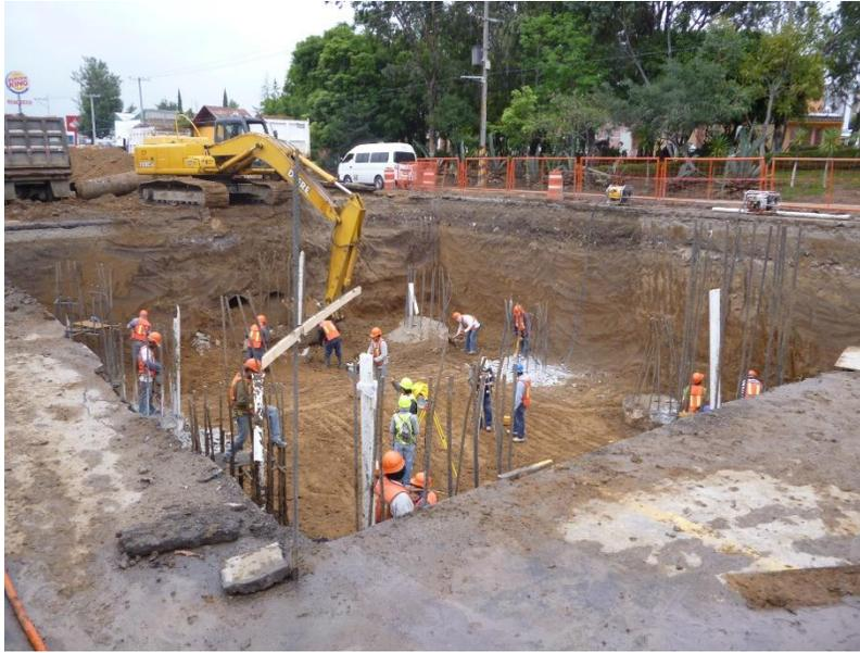
(1) Imagen 3.13 Excavación de zapata. Fuente del autor.
