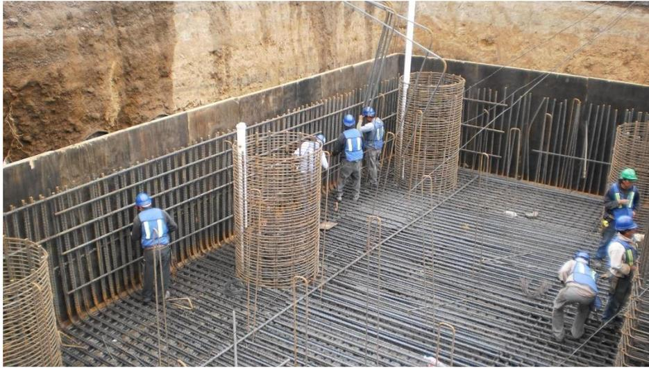
(1) Imagen 4.3 Armado de zapata losa inferior. Fuente del autor.
