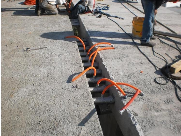
(1) Imagen 7.4 conexión de ductos de presfuerzo. Fuente del autor.
