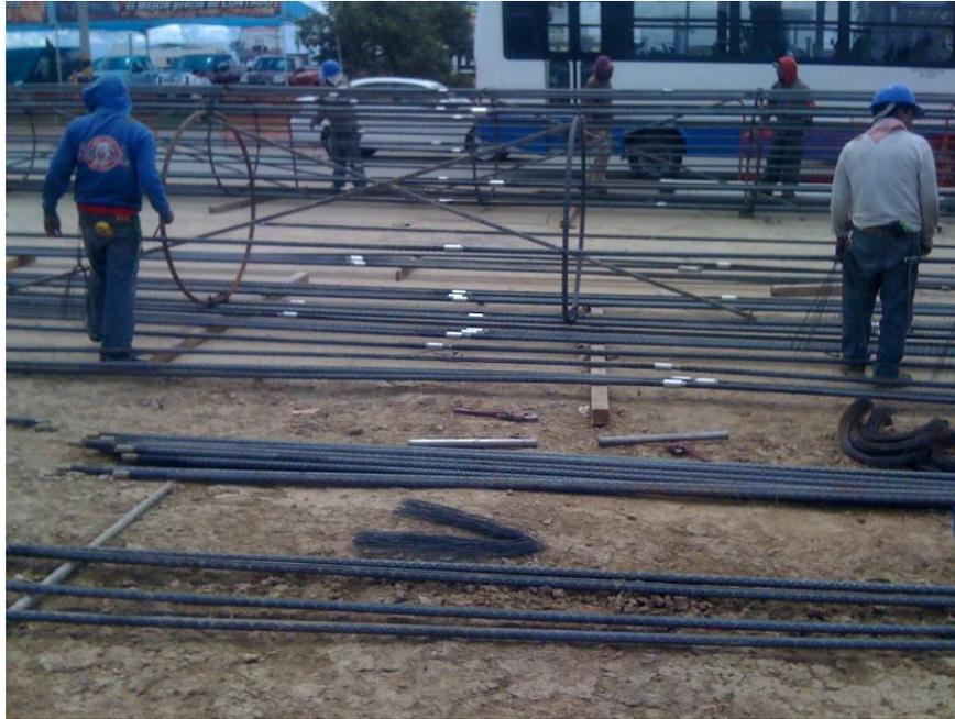
(1) Imagen 3.3 armado de pila de cimentación. Fuente del autor.
