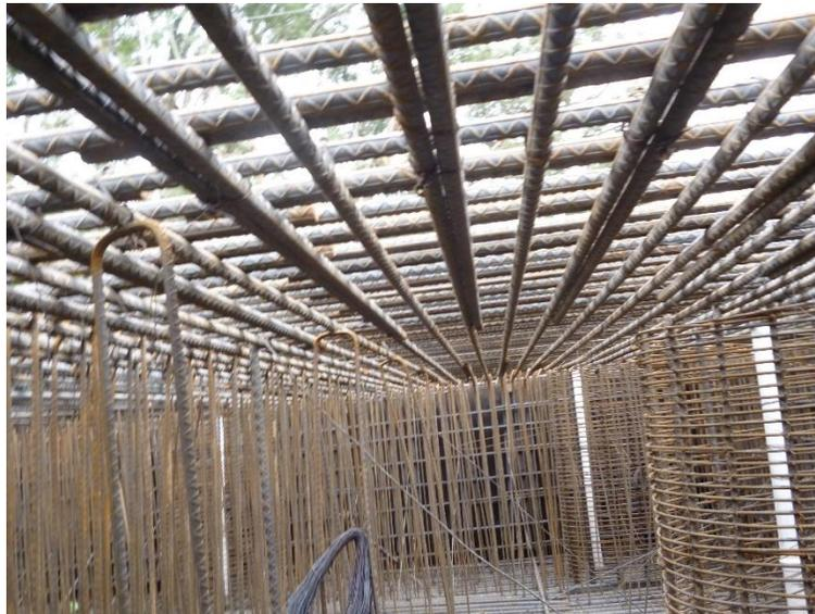
(2) Imagen 4.8 Armado interior zapatas. Fuente del autor.
