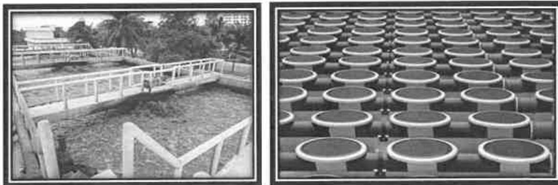
*Figura 22: Tanque de aireación con aireadores superficiales y difusores de burbuja fina*
