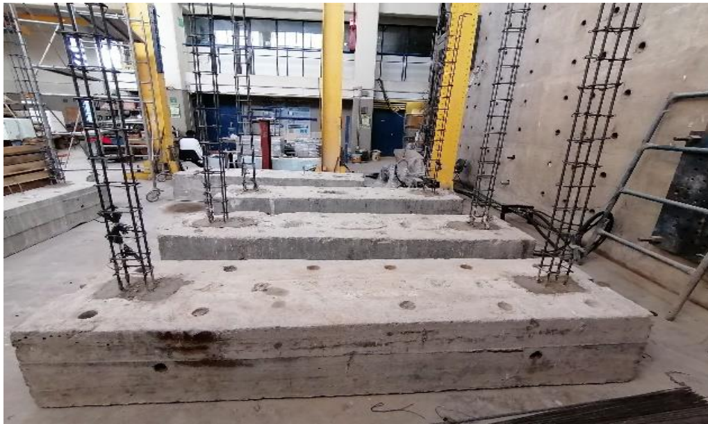
a. Castillos colocados en las zapatas de cimentación
