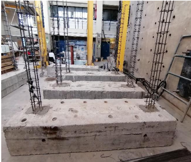
a. Primera etapa de colado (castillos –cimentación).
