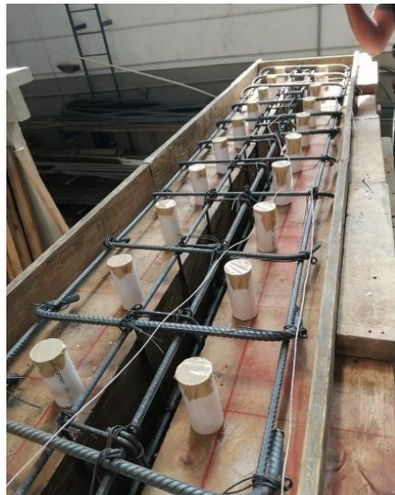
a. Cimbrado de confinamiento superior.
