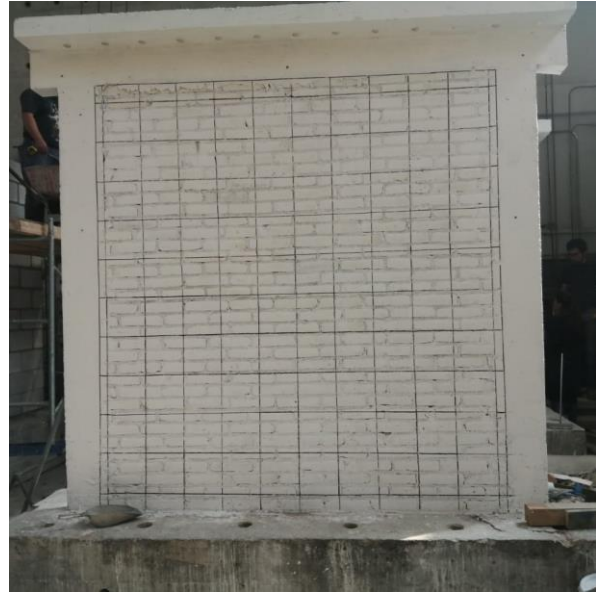
b. Cuadrícula para monitoreo de grietas.
