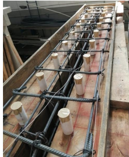
b. Colocación de cimbra y armado de losa
