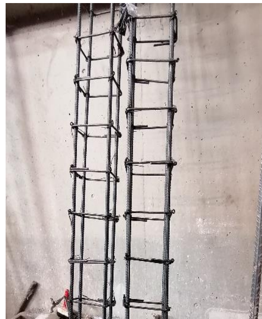
b. Armado de castillos sencillos.
