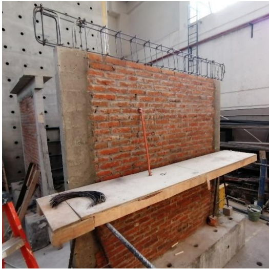
a. Colocación de acero para dala
