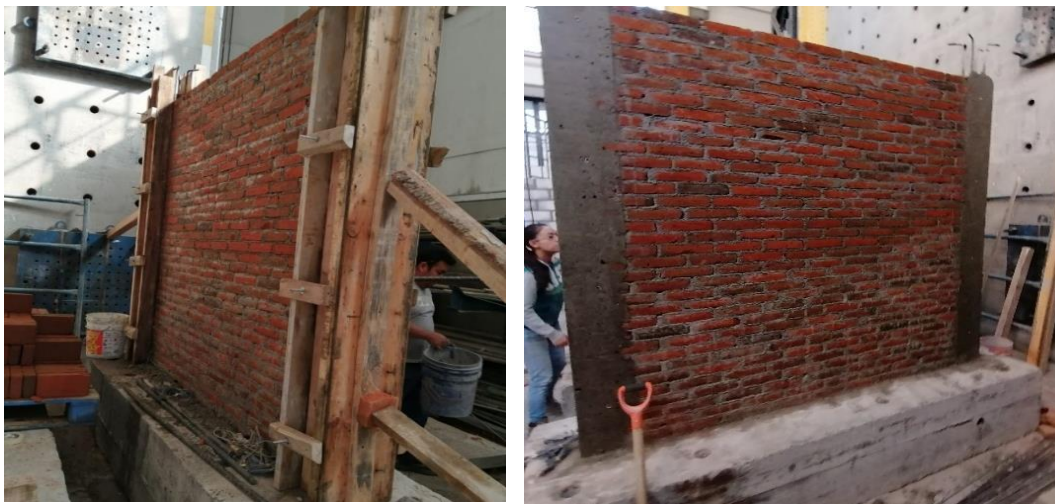
a. Colocación cimbra para castillos.
