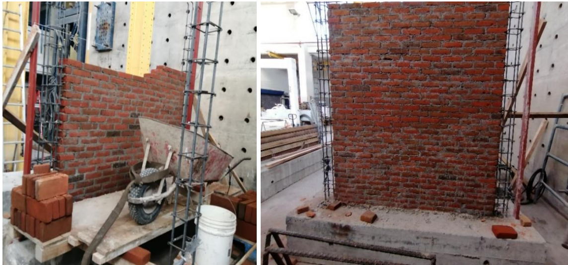
a. Colocación de hiladas de las piezas.
