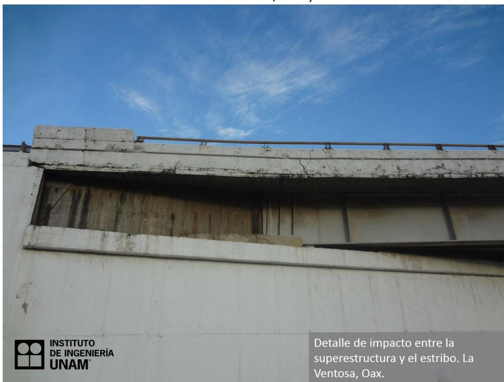
Figura 2.25 Impacto del tablero con el diafragma del estribo (Pozos Estrada et al., 2017)
