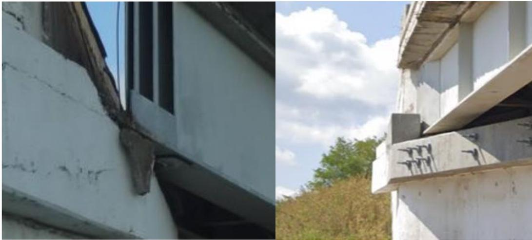
*Figura 2.35 Comparación tope sísmico anterior y actual*
