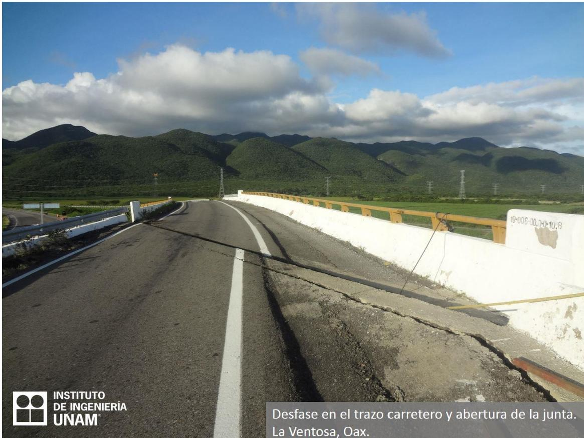
*Figura 2.26 Desfase máximo del tablero respecto al trazo carretero (Pozos Estrada et al., 2017)*
