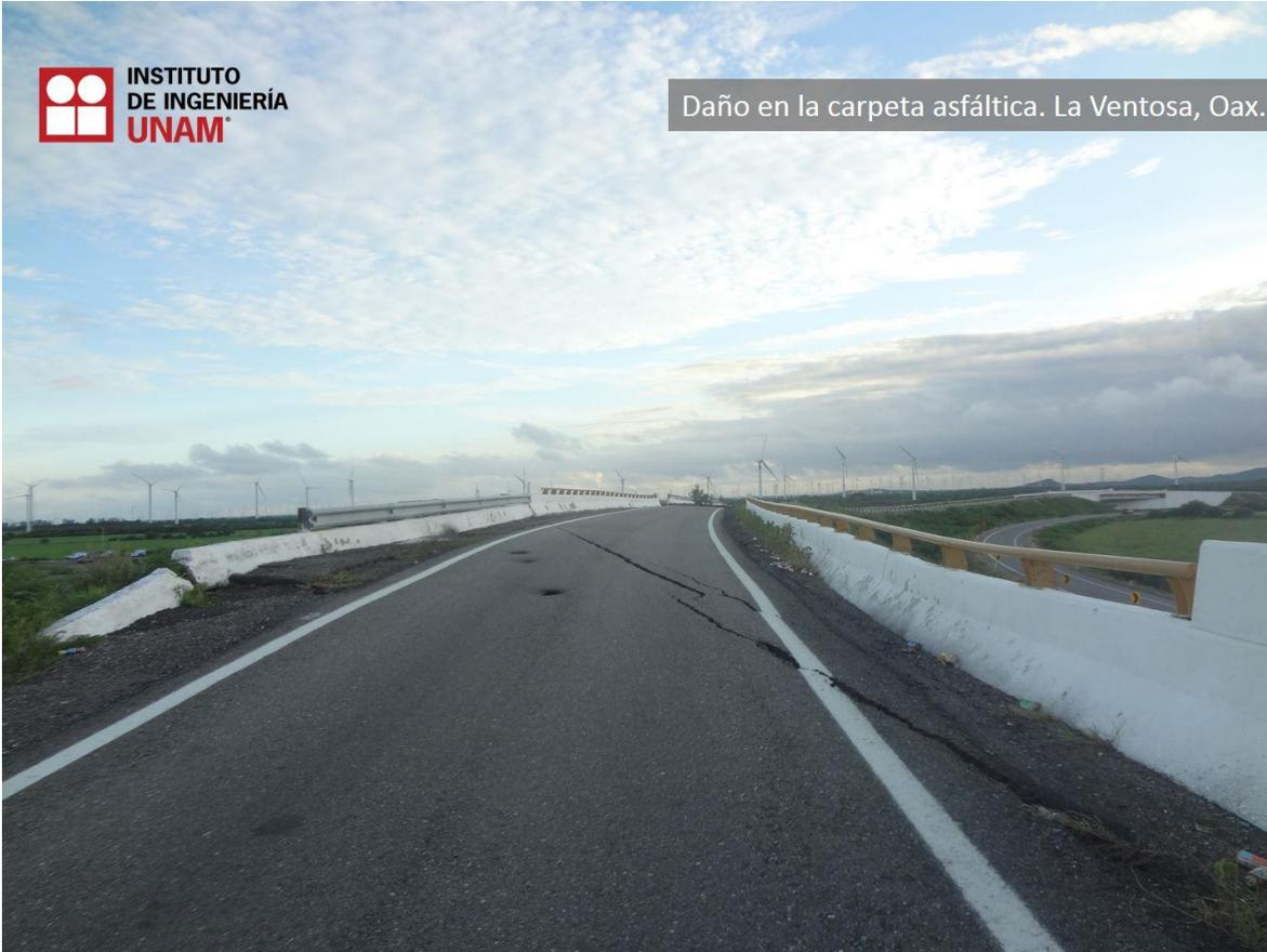
Figura 2.27 Desfase mínimo del tablero respecto al trazo carretero (Pozos Estrada et al., 2017)
