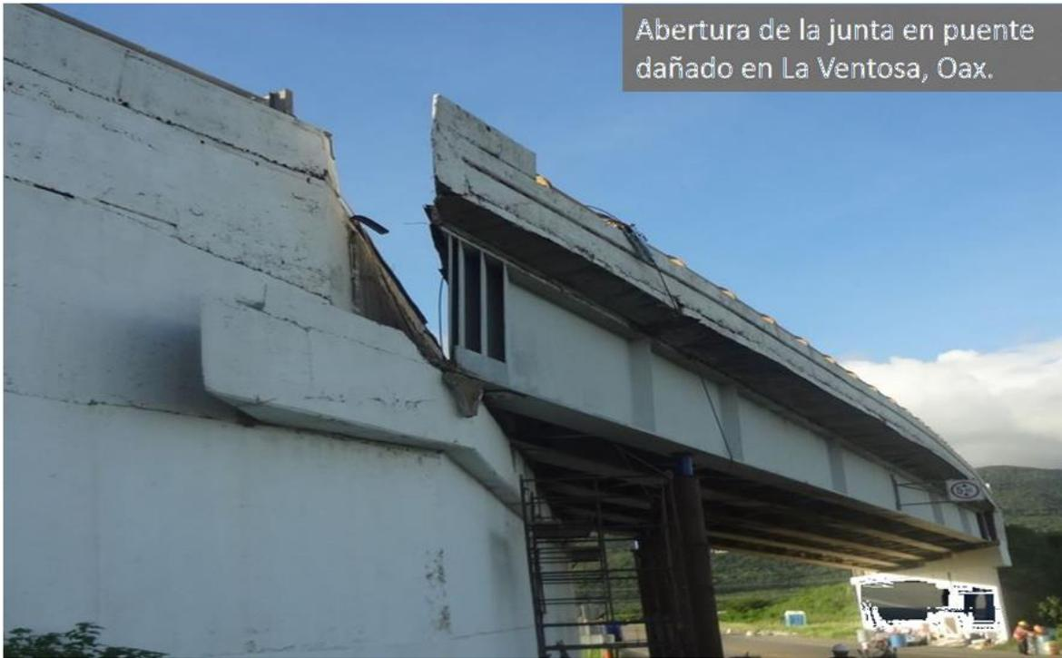
Abertura de la junta en puente dañado en La Ventosa, Oax.
