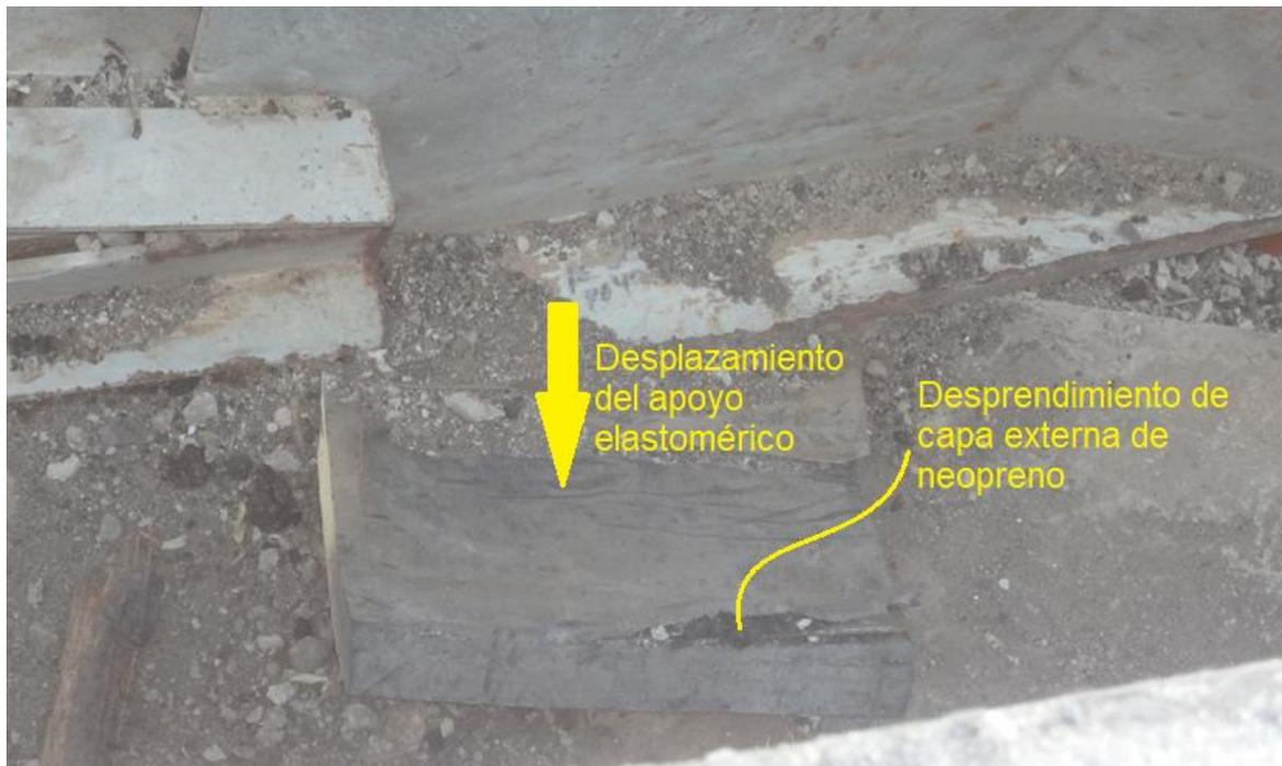
Figura 2.34 Daño y exposición de apoyo elastomérico tras rotación del puente La Ventosa (Pozos Estrada et al., 2017)
