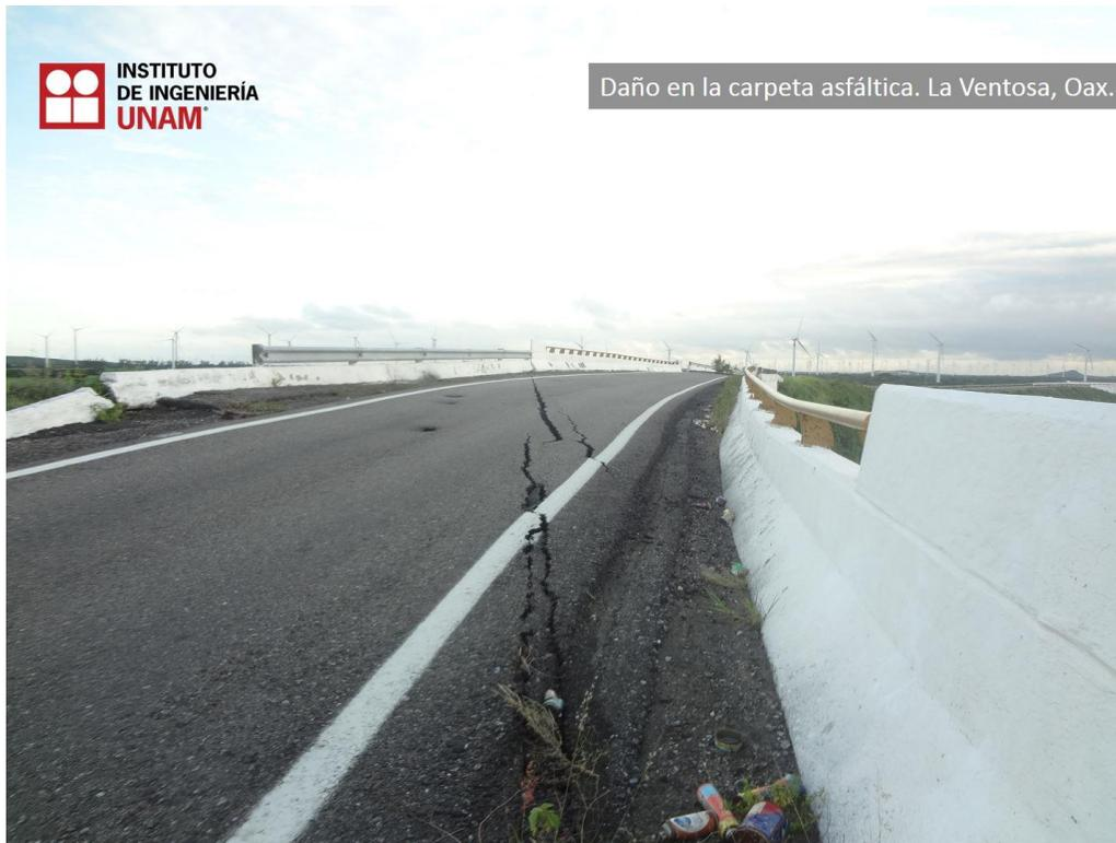
Figura 2.24 Agrietamiento en carpeta asfáltica tras impacto del tablero con el estribo (Pozos Estrada et al., 2017)
