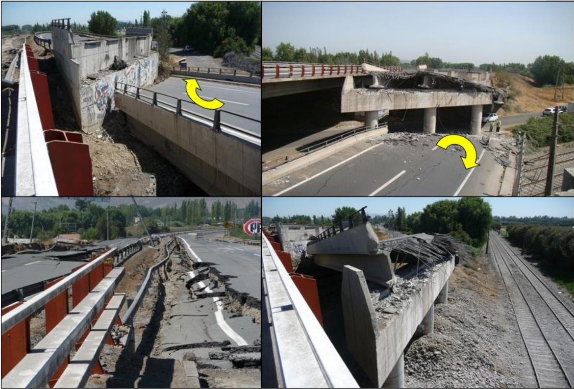
Figura 2.19 Daños en PS FFCC Hospital -Santiago-Talca-Ruta 5 sur (Unión, 2015)
