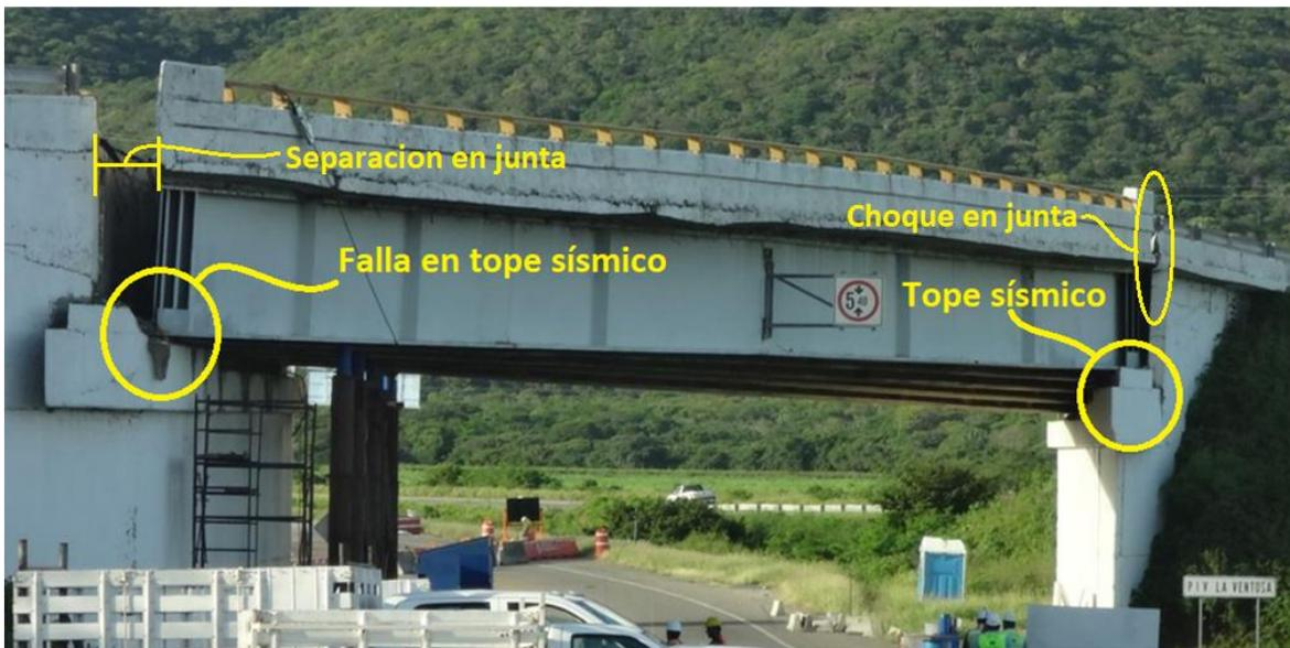
Figura 2.21 Efectos en puente esviado La Ventosa tras el sismo del 7/9/2017 (Pozos Estrada et al., 2017)
