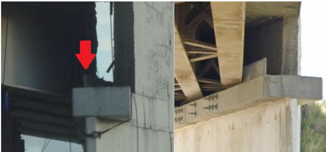
*Figura 2.36 Comparación tope sísmico anterior y actual 2*
