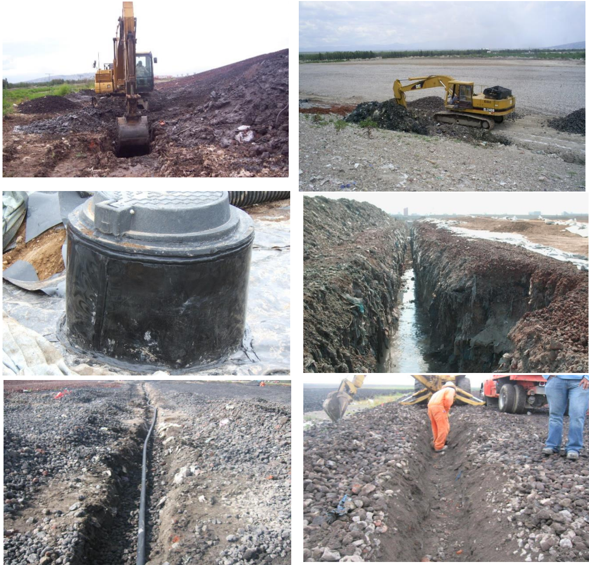
Trabajos de excavación y pozos de visita dren perimetral para recolección de lixiviados, tendido de tuberías para infiltración de lixiviados.
