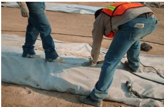
Conexión de tubería a dren perimetral, fusión del geotextil y tubería en estadio
