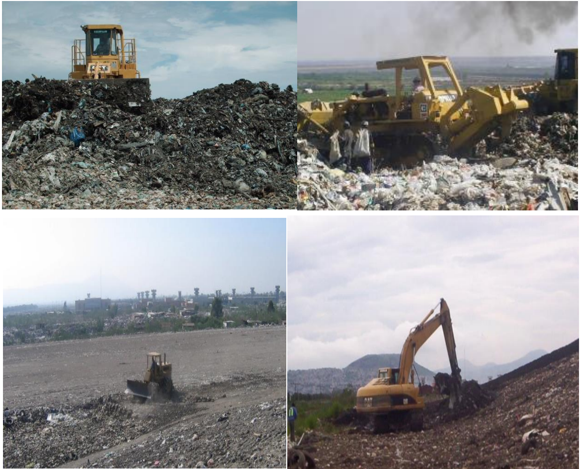
Conformación de plataformas y taludes
