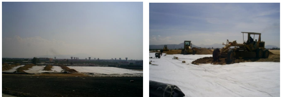
Sello: Colocación de segunda capa de limo arenoso (tepetate)
