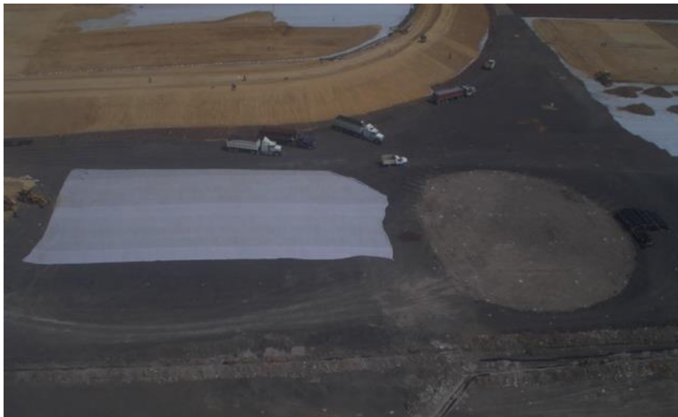
Trabajos de sello: colocación de primera capa de geotextil
