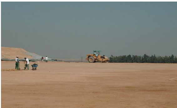
Trabajos de sello: colocación de primer capa de tepetate
