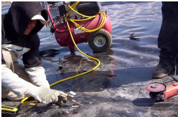
Prueba de hermeticidad de la soldadura de la geomembrana
