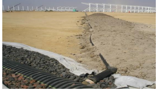
Colocación de tubería para drenaje de plataformas y conexión a dren perimetral
