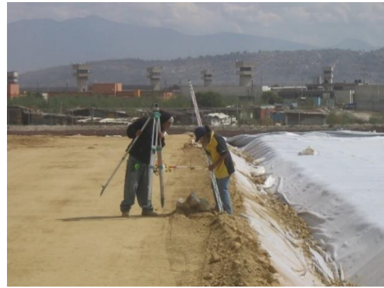
Zanjas para anclaje de geocompuesto
