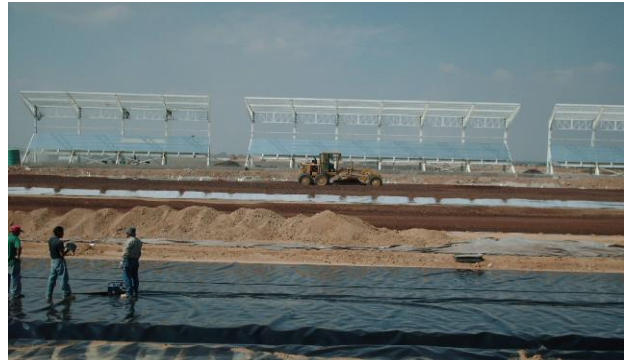
Colocación, traslape y soldadura de geomembrana PAD de 1 mm
