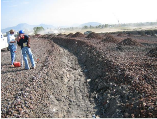
Zanjas para anclaje de geocompuesto
