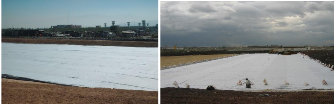
Sello: Colocación de segunda capa de geotextil (sobre la geomembrana)
