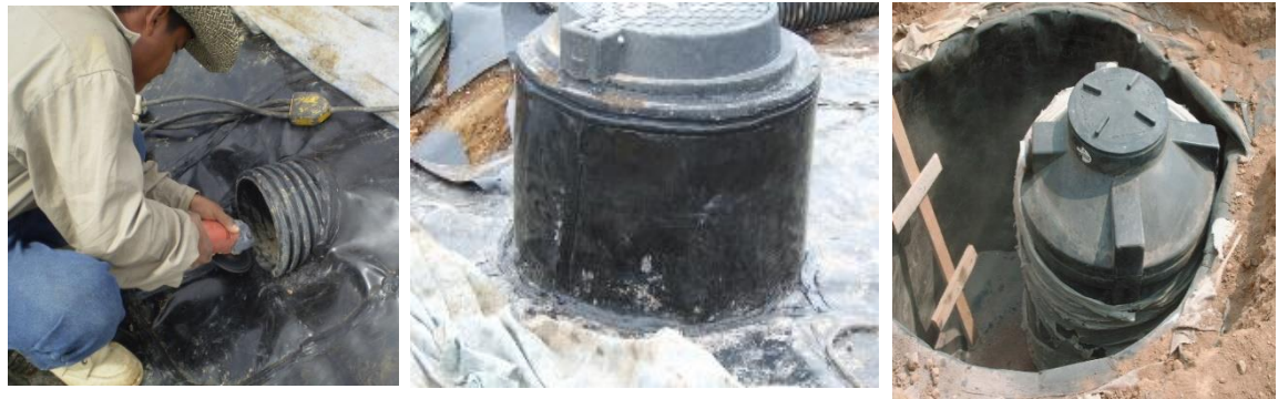
Sello: soldadura de geomembrana con registros y tubos en instalaciones.
