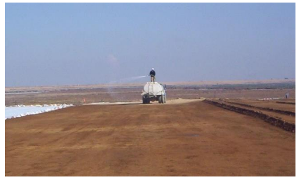
Trabajos de sello: colocación de primer capa de tepetate
