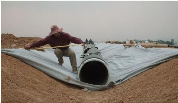
Colocación de tubería para drenaje de plataformas y conexión a dren perimetral
