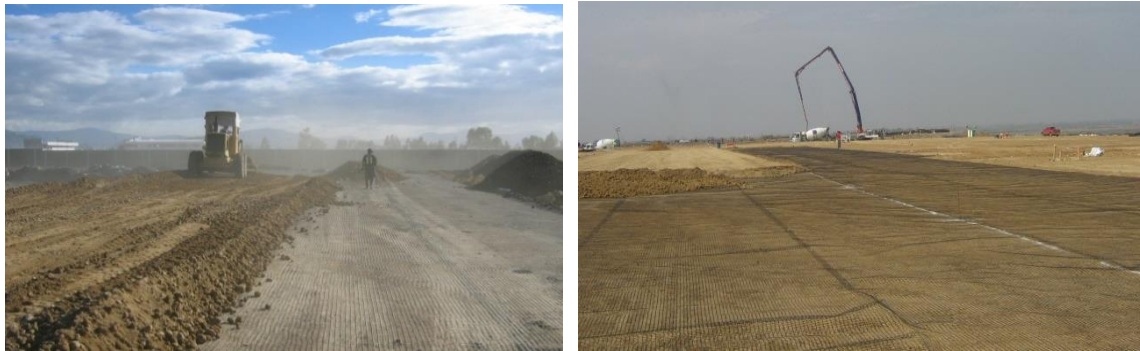
Colocación de mejoramiento para plataformas.
