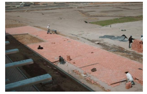
Armado, colado y sello de juntas de los firmes de las canchas, Trabajos de albañilería y acabados en canchas, colocación de adoquín en los andadores.
