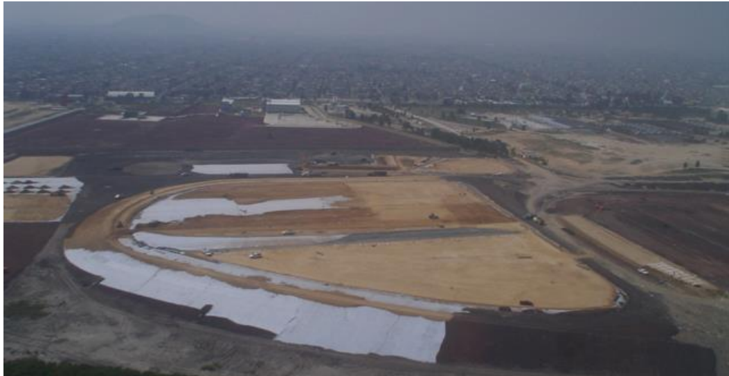
Trabajos de sello: colocación de primer capa de tepetate
