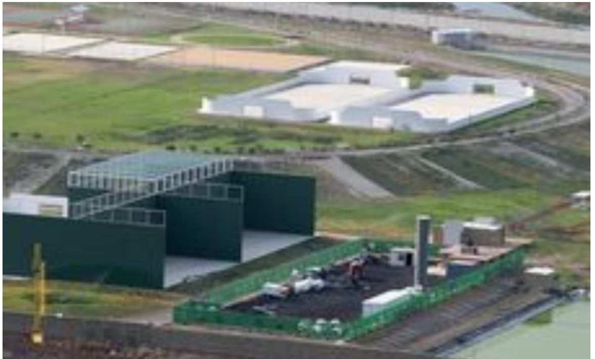
Zona de extracción y quema. Chimenea de flama cerrada y equipos de extracción y quema de biogás
