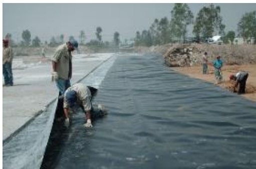
Colocación, traslape y soldadura de geomembrana PAD de 1 mm
