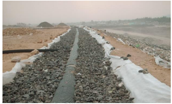
Colocación de tubería para drenaje de plataformas y conexión a dren perimetral
