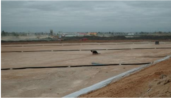
Colocación de tubería para drenaje de plataformas y conexión a dren perimetral
