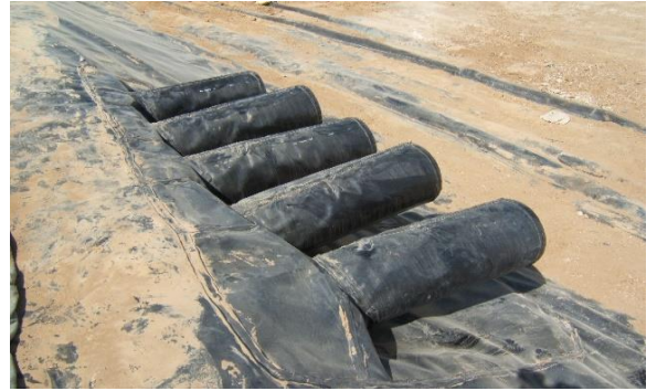
Sección de las lagunas y tuberías de llenado provenientes de las plataformas
