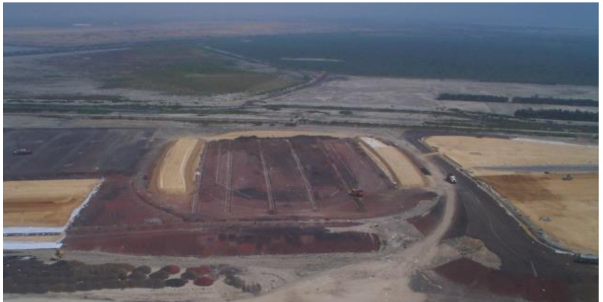
Trabajos de sello: colocación de tezontle en plataformas
