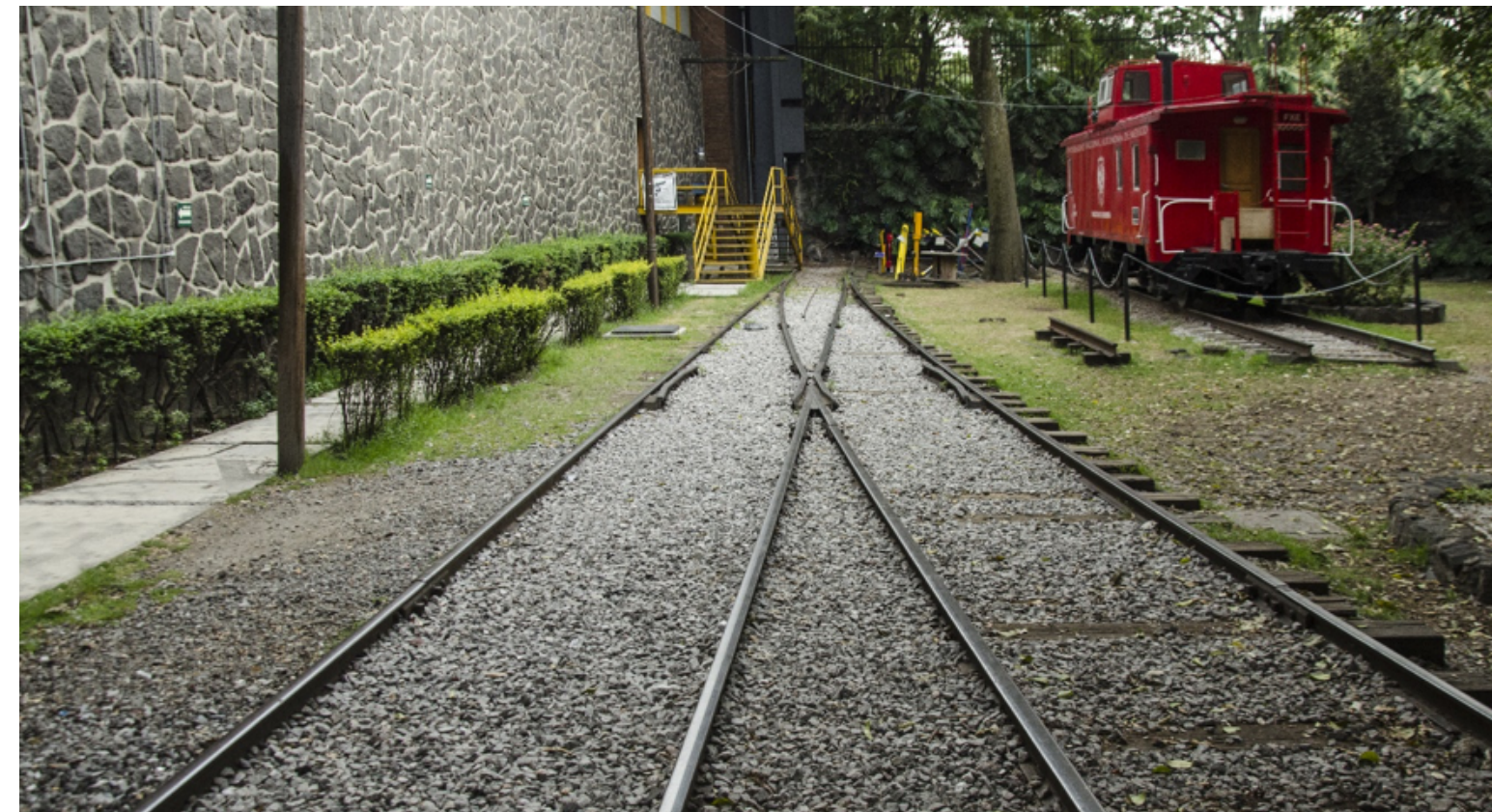
Figura 86. Vías de acero con durmientes de madera. Al fondo se encuentra el cabús que se apoya sobre una vía de acero con durmientes de concreto
