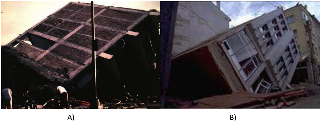
Figura 1.3: Ejemplificación de ruptura por capacidad de carga. A) Edificio dañado en la ciudad de México (1985). B) Edificio dañado de Adapazari por el sismo de Kocaeli, Turquía (1999). (Tomada de: Chatzigogos C., 2007).
