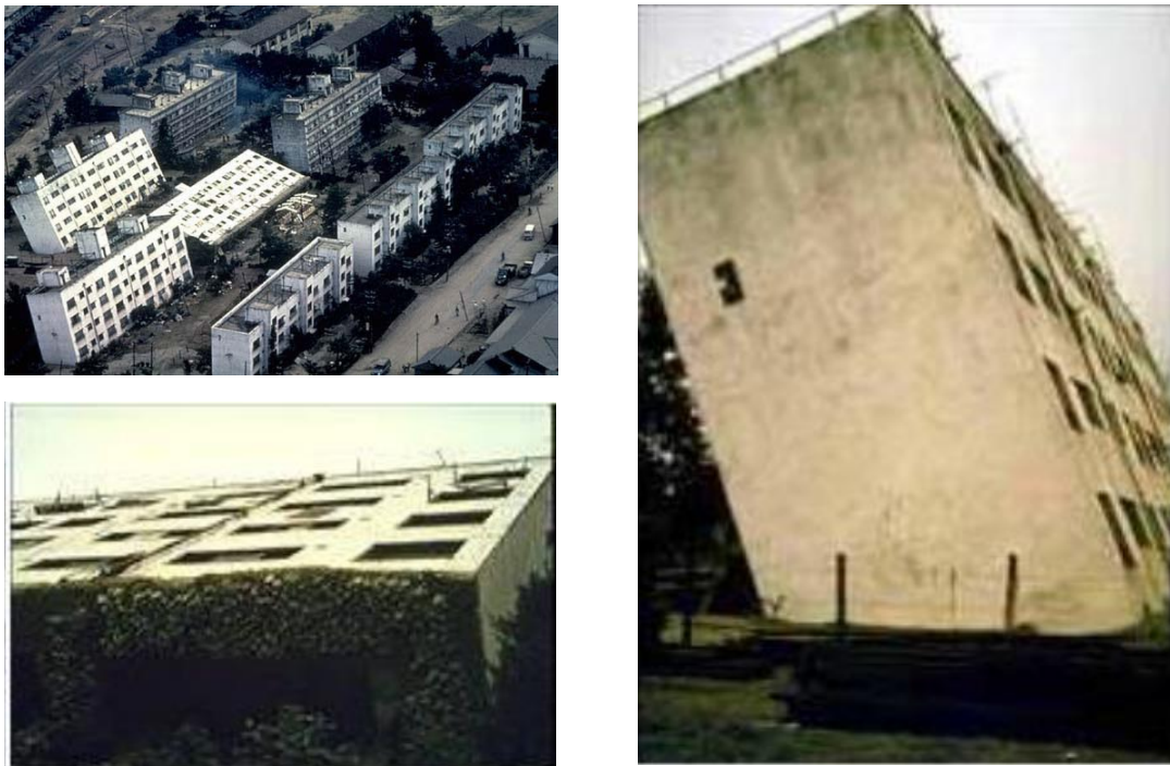
Figura 1.2: Daños por capacidad de carga en el sismo de Niigata, Japón (1964) donde se resalta la estructura intacta de los edificios (Tomada de: Chatzigogos C., 2007).
