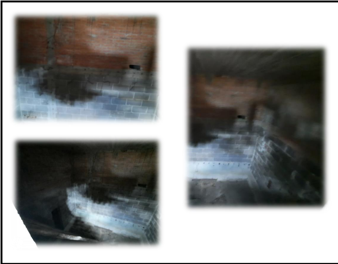
Figura 5.40: Fotografías del cajón de cimentación del edificio de estudio B1).
