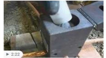
Conectores de soldadura exotérmica
