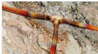
Conectores de soldadura exotérmica
