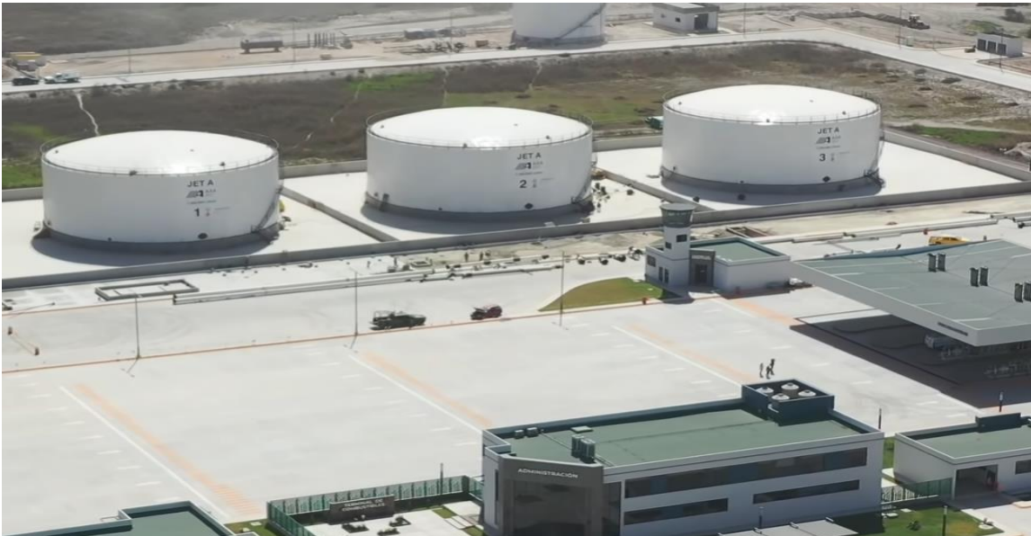
Figura 5.13 Terminal de combustibles del Aeropuerto Internacional Felipe Ángeles. (AIFA Combustibles, 2021).
