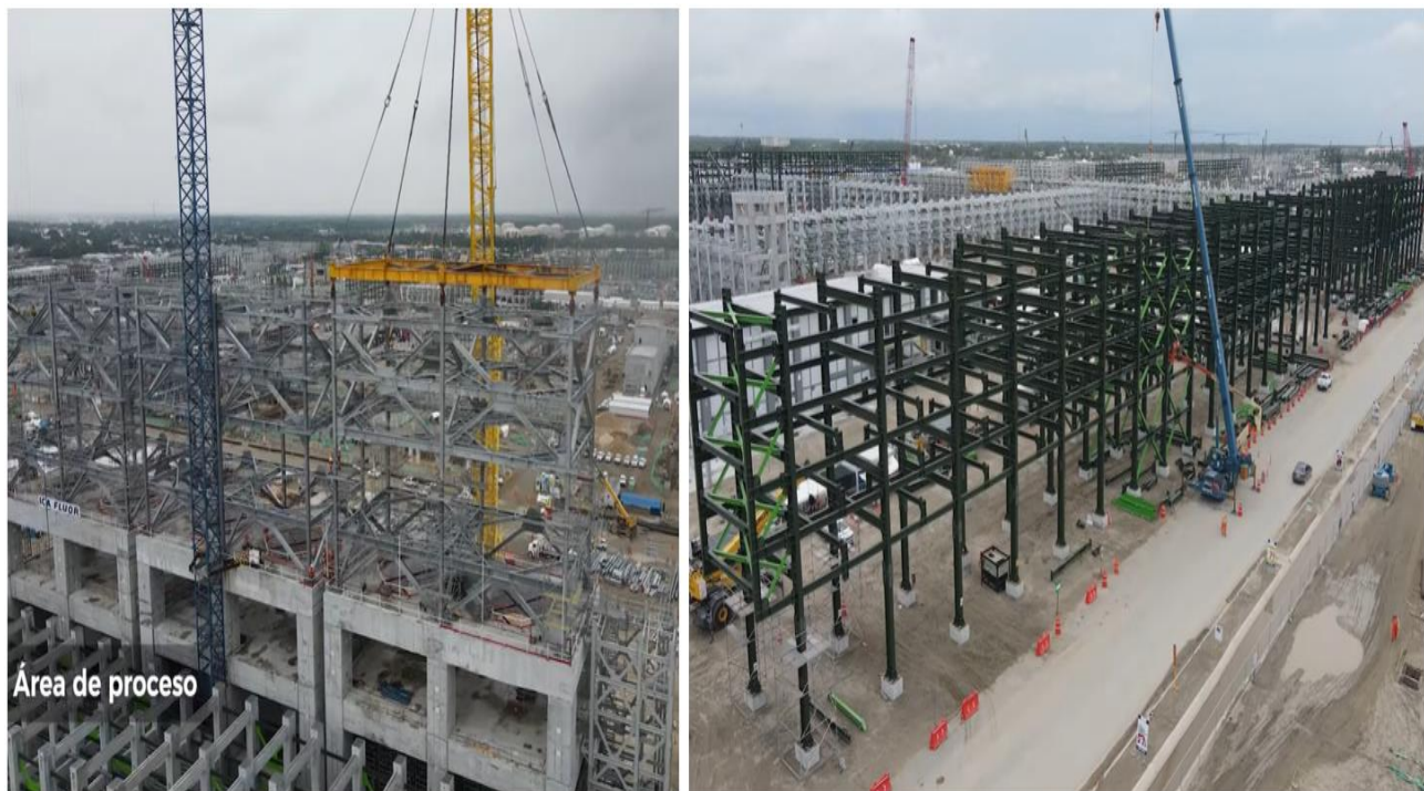
Figura 5.15 Refinería de Dos Bocas en construcción. (SENER, 2021).
