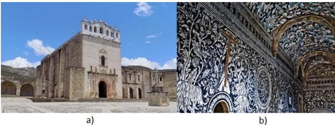
Figura 2.1. a) Edificación de exconvento de los Reyes de Meztitlán, Hgo., b) Frescos del convento agustino en Malinalco, Edo. México.
