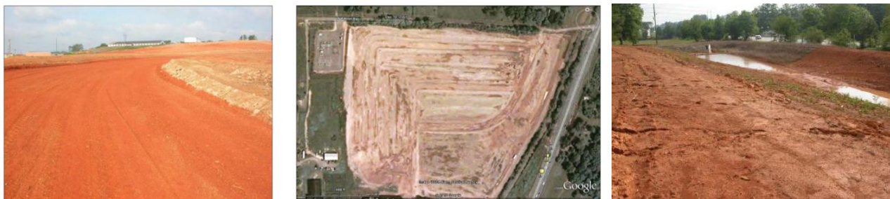
Fig. 4 Imágenes de Google Earth en las que se aprecian los 30 acres despejados.
