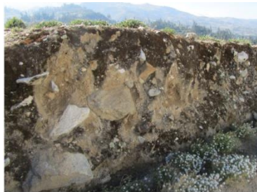
Fig. 8 Depósito de Flujo de escombros.
