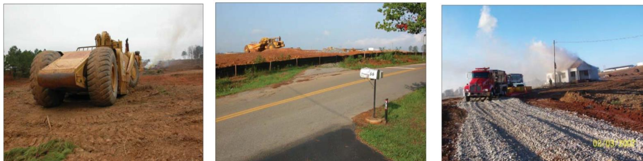
Fig. 3 Trabajos de deforestación y quema de vegetación para el Proyecto de Legacy Cove.
