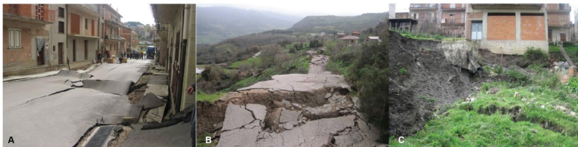
Fig. 12 Daño a la infraestructura resultado del deslizamiento en 2010.
