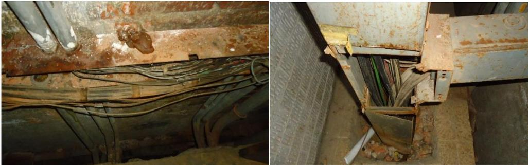
**Figura 28. Canalización principal oxidada**
