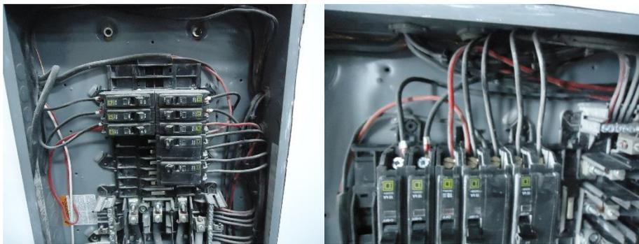
**Figura 13. Interruptores a la izquierda, detalles cables de circuitos 2, 4, 6, 8, 10, 12 y 14 a la derecha**
