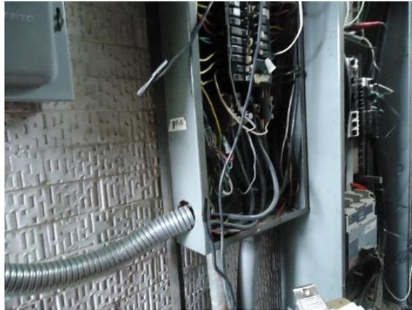
**Figura 10. Tablero PBA, cables sueltos**
