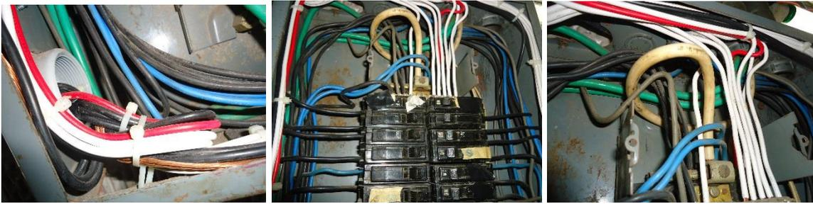
**Figura 19. Estado de los cables en el tablero P1A.**
