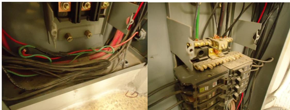
**Figura 24. Cables, pastillas y zapatas del tablero P1D.**
