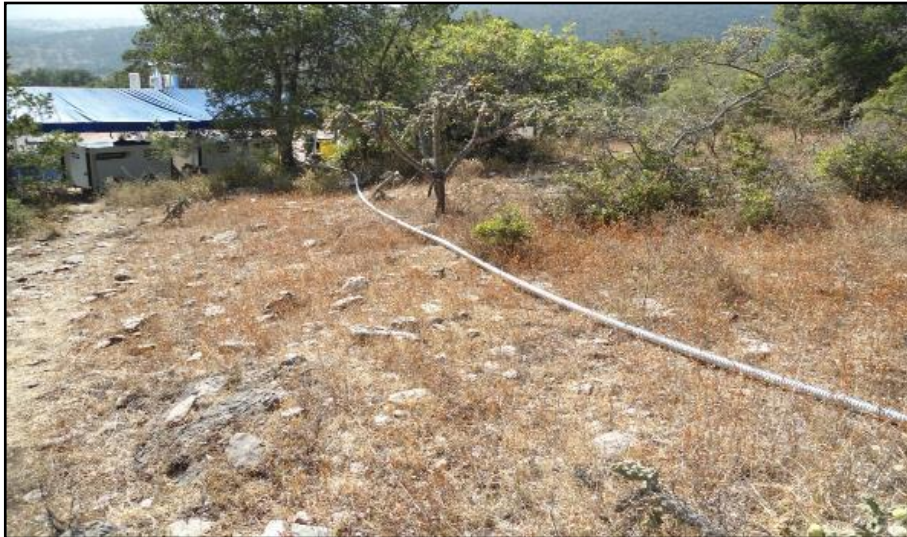
Ilustración 22. Conexión de equipo a subestación.
