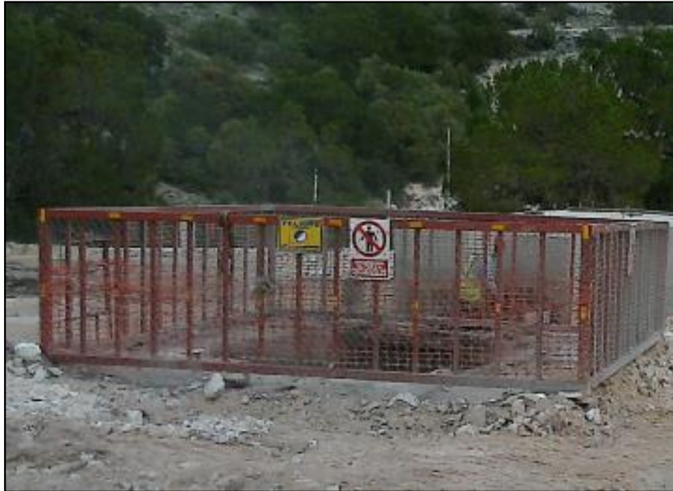
Ilustración 30. Colocación de la barricada en el contrapozo
