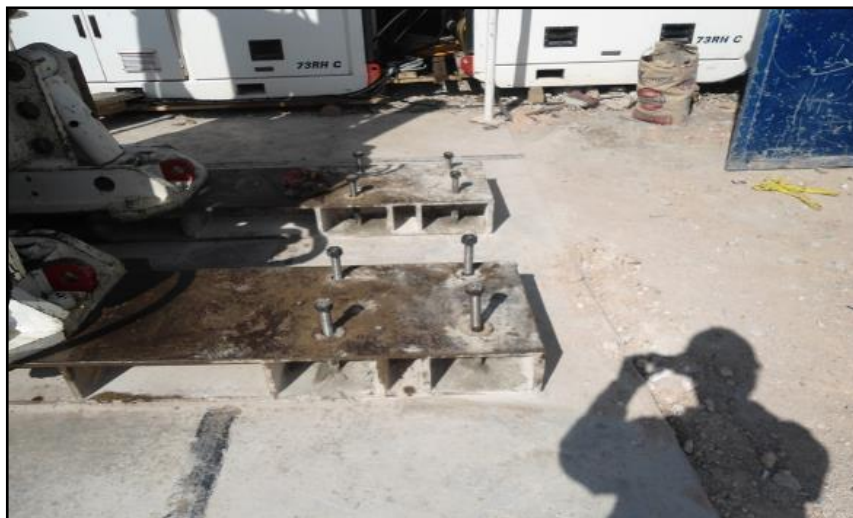
Ilustración 21. Fijación del equipo en su ubicación
