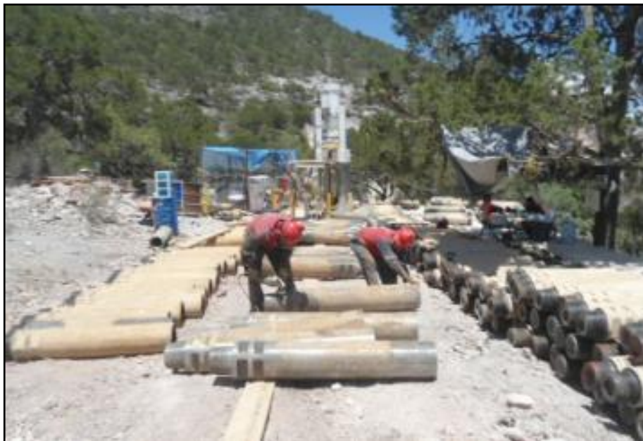
Ilustración 29. Desinstalación tubería contrapocera pozo Master Drilling
