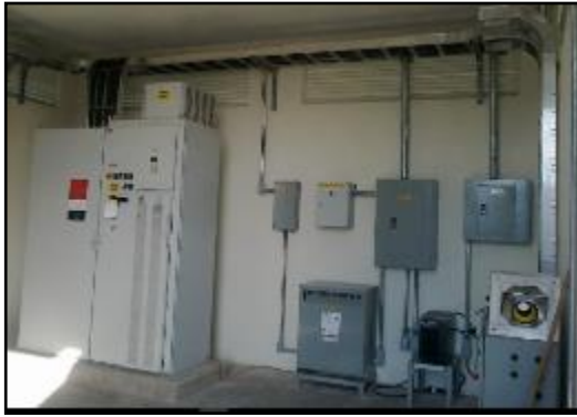
Ilustración 34 y 35. Variador de frecuencia y prueba de arranque y paro
