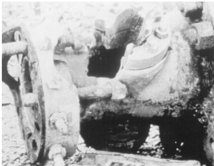
Figura 2.2: Falla del estrangulador debido a la producción de arena. (Penberthy, 2006)
