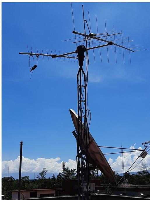
**Figura 3.5:** Antenas tipo yagi VHF y UHF de la estación terrena
