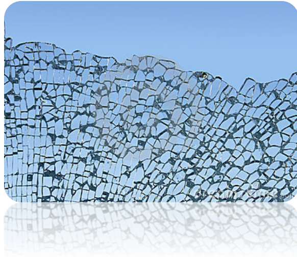
Figura 2.12. Falla de vidrio templado
