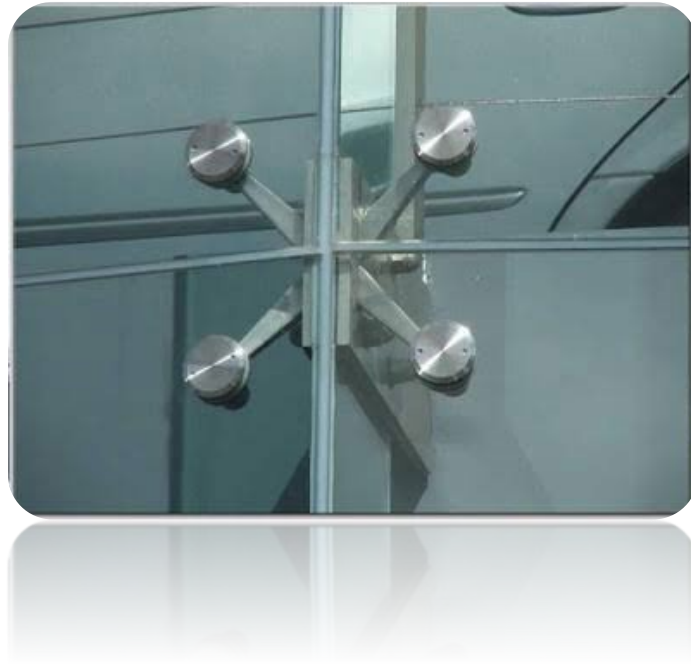
Figura 2.14. Sellador en fachada acristalada
