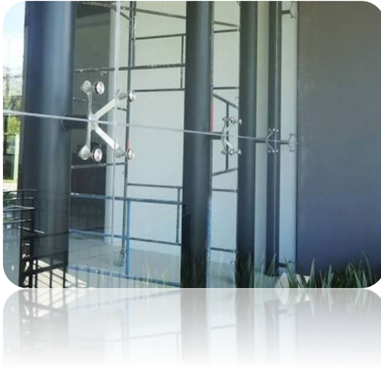
Figura 2.15. Sistema de soporte de araña a estructura
