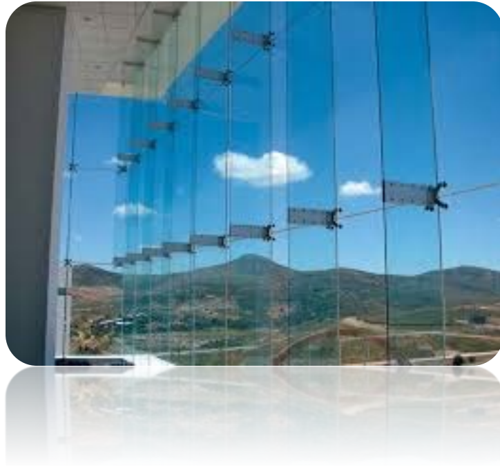
Figura 2.17. Sistema de soporte de araña a costilla
